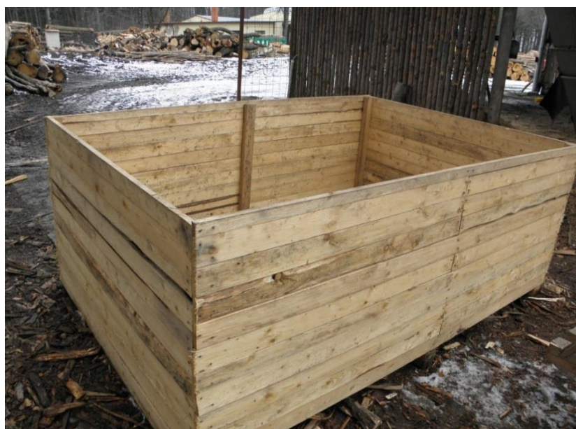
Obr. 5: Dřevěná odměrná nádoba o objemu 5 prm.
