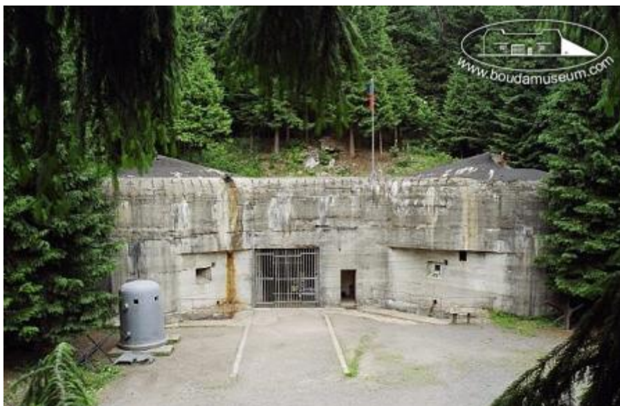
Obrázek 6. Vchodový objekt tvrže Bouda K–S 22a „Krok“
