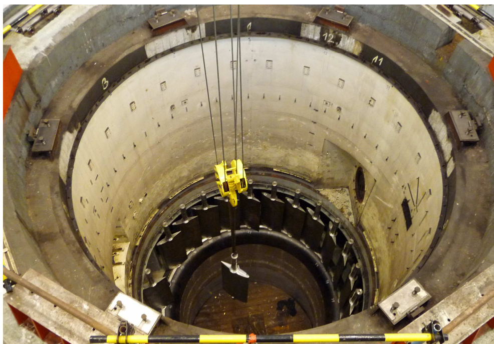
Obr. 3 Turbínová šachta, usazování rozváděcích lopat, foto autor
