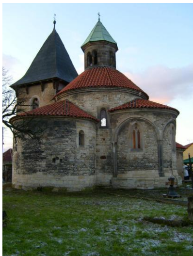
Obr. č. 29: Pohled od jihovýchodu
