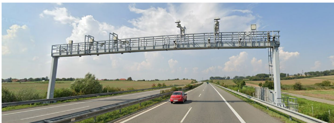
Obrázek 4.2: Záběr na měřicí stanoviště firmy Cross u Tlumačova na D55 [36]
