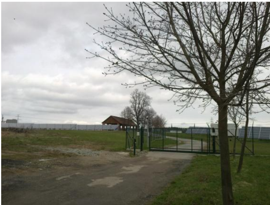
Obr. 11 Hlavní vjezd a příjezdová komunikace do FV elektrárny Ševětín, autor Jan Trnobranský, 8. 4. 2012
