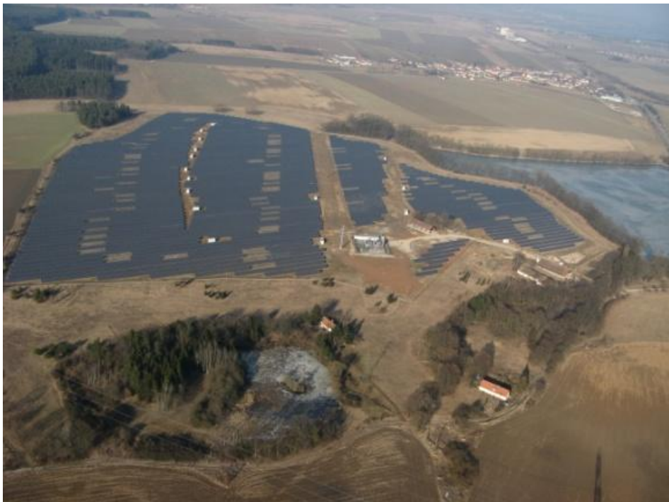
Obr. 15 Západní blok FV elektrárny Ševětín s el. rozvodnou, autor David Sochr, 5. 3. 2011
