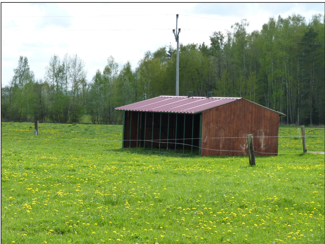
Obr. č. 4 Mobilní přístřešek na pastvině
