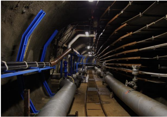
Obrázek 18: Vedení potrubí v podzemních kolektorech, [52]
