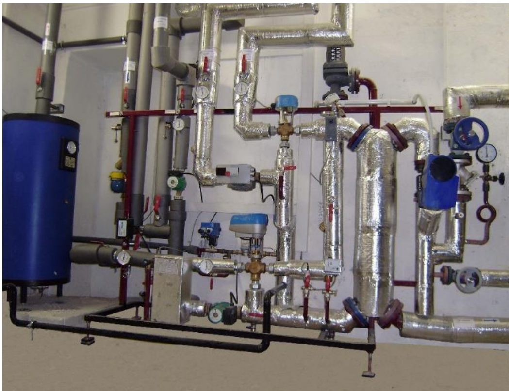
Obrázek 26: Tlakově nezávislé předávací stanice, [58]
