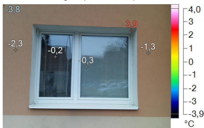
Obrázek 58: Detail plastového okna
