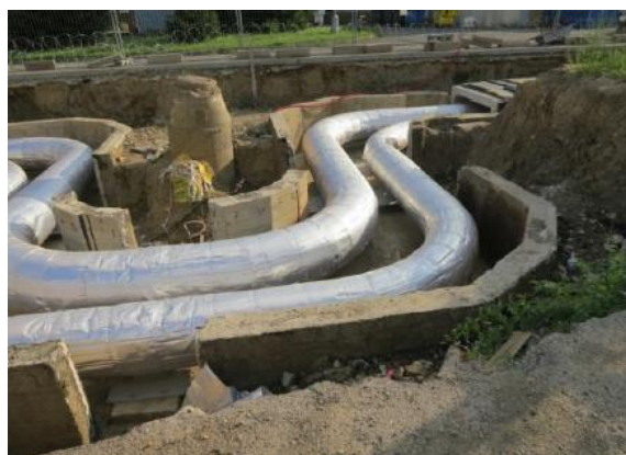
Obrázek 16: Uložení potrubí v kanále, [44]
