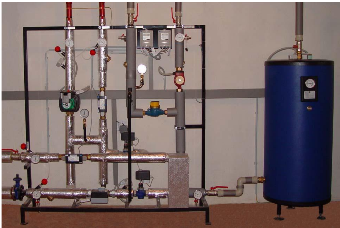
Obrázek 25: Tlakově závislé předávací stanice, [57]
