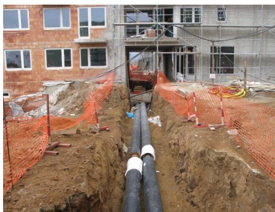
Obrázek 17: Uložení potrubí přímo v zemi, [51]
