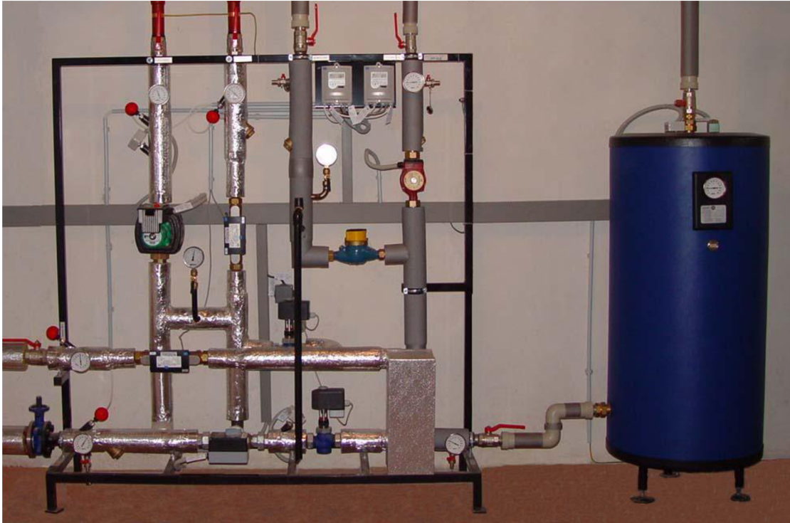
Obrázek 25: Tlakově závislé předávací stanice, [57]
