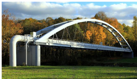
Obrázek 15: Potrubní most Baška, [50]
