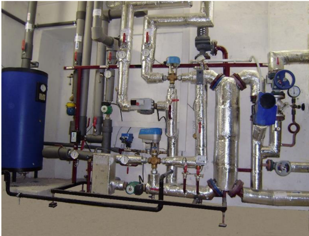
Obrázek 26: Tlakově nezávislé předávací stanice, [58]
