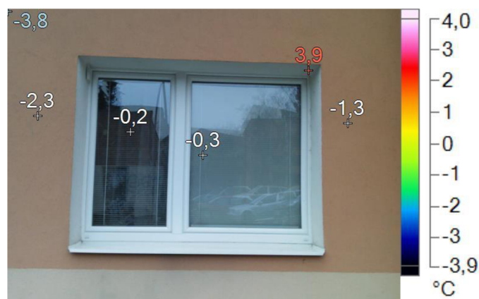
Obrázek 58: Detail plastového okna
