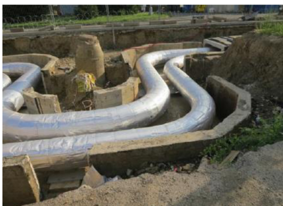
Obrázek 16: Uložení potrubí v kanále, [44]
