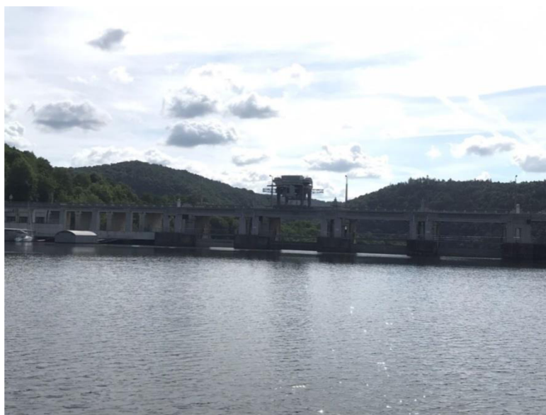
Obrázek 2: Hráz vodní nádrže Slapy (Vlastní fotografie, 2022)
