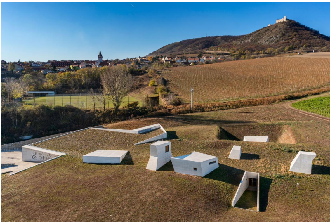
Obr.2 Archeologický park Pavlov – venkovní pohled [23]
