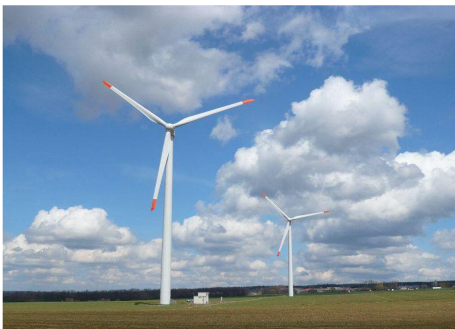
Obrázek 4 - Velká větrná elektrárna
