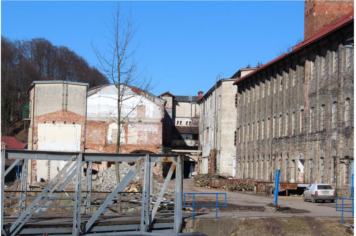
Obrázek 3: postupná demolice papírenských budov
