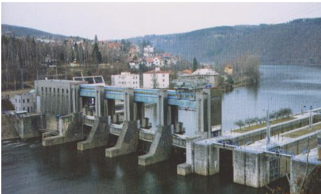
Příloha č. 3 - VD Vrané, vlevo budova hydroelektrárny
