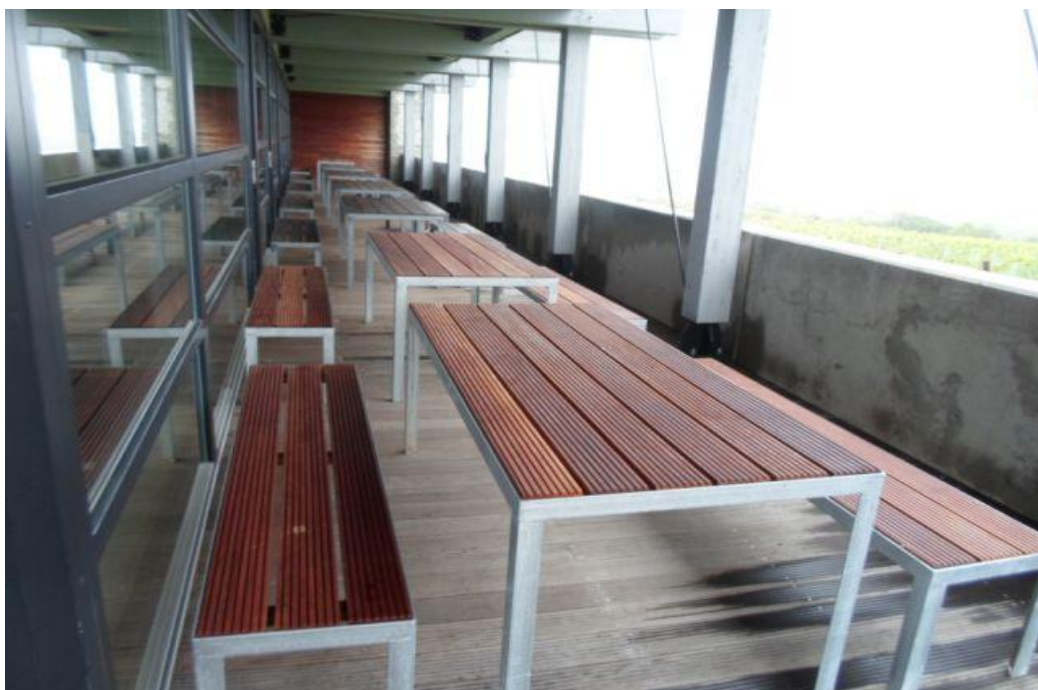
[19] Martin Bukolský, vinařství Gotberg v Popicích, 2006-2009, pohled na betonové zábradlí
