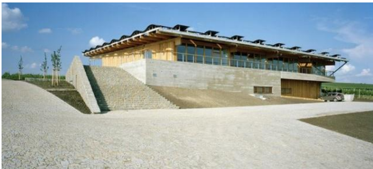
[11] Josef Pleskot, vinařství Sonberk v Popicích, 2006-2007, čelní pohled
