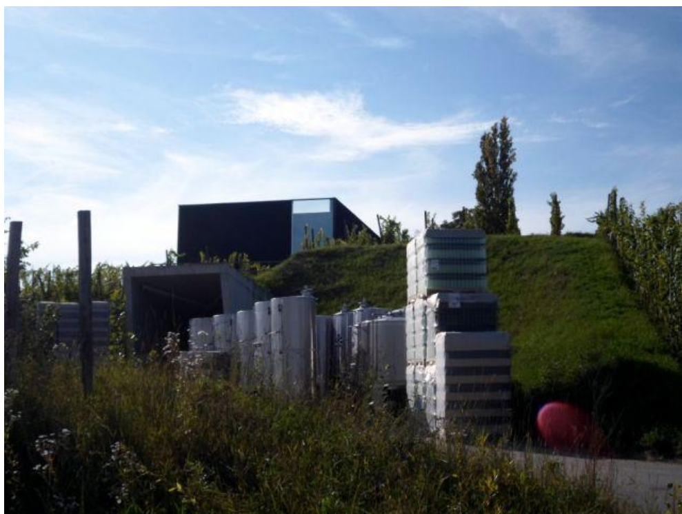
[30] Andreas Burghardt, vlnářství Fred Loimer v Langenlois, 1999-2008, čelní pohled na vlnářství s technologií
