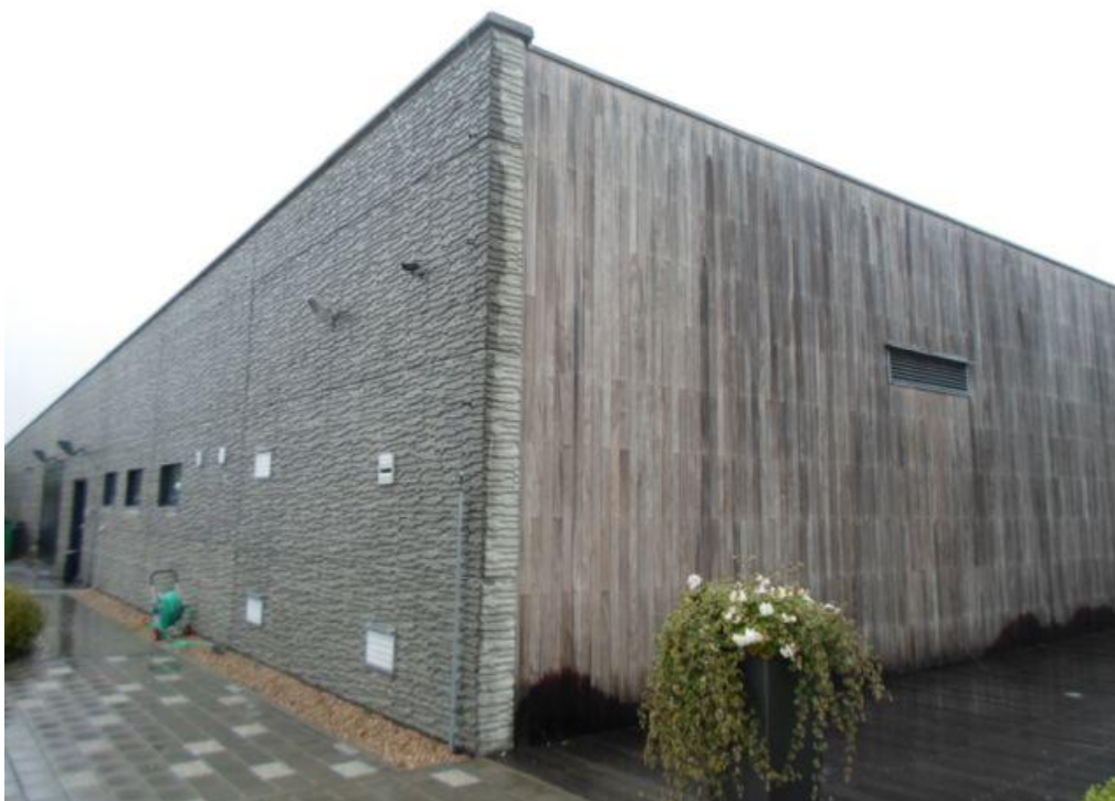
[17] Martin Bukolský, vinařství Gotberg v Popicích, 2006-2009, pohled na technologickou budovu
