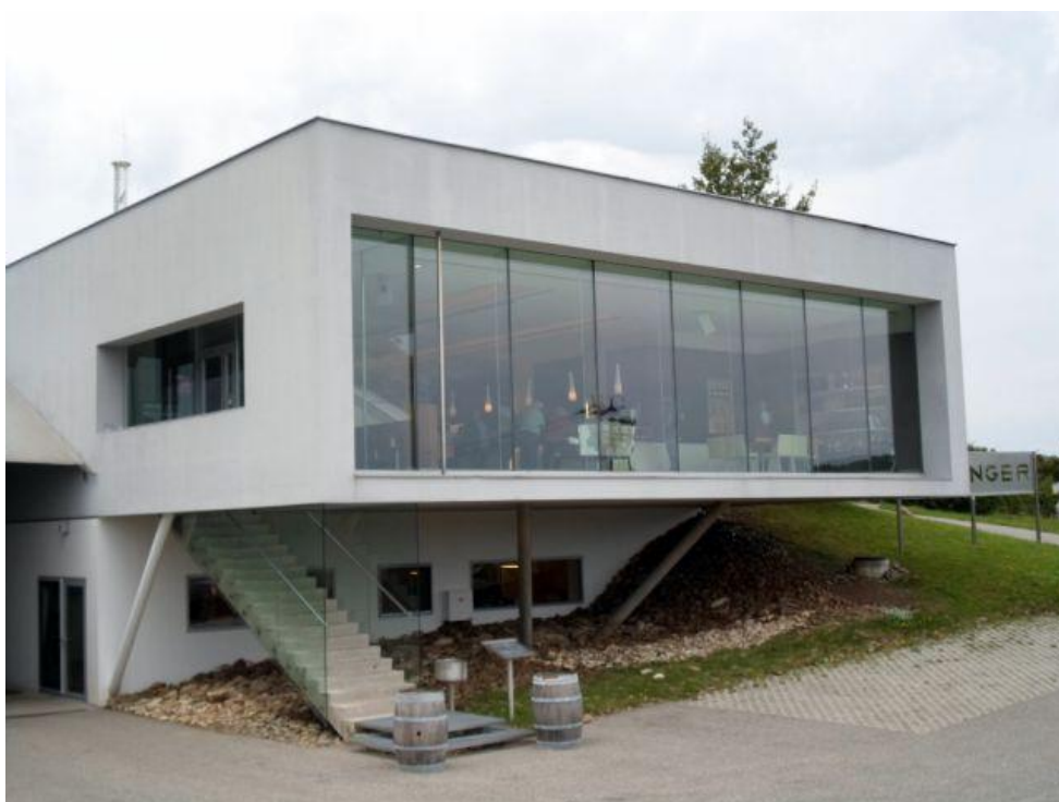
[25] Ateliér gerner°gerner plus, vinařství Leo Hillinger v Joisu, 2001-2004, čelní pohled
