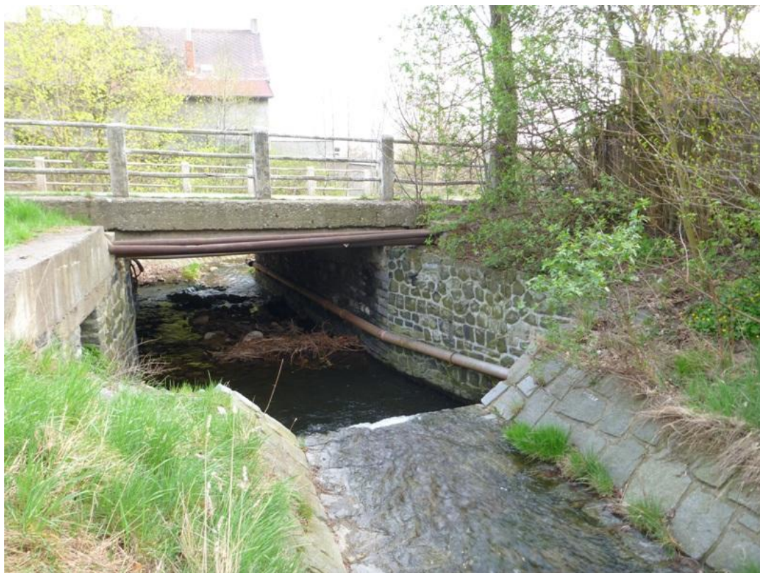
obr. č. 38 Silniční most křížící trasu Jiřetínského potoka – směr po proudu toku (Šíma 2014).
