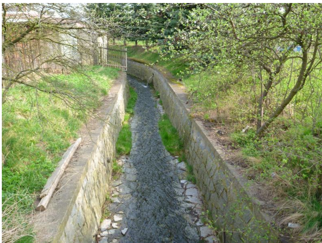
obr. č. 37 Jiřetínský potok v úseku ř. km 2,502 až 2,893 – směr po proudu toku (Šíma 2014).
