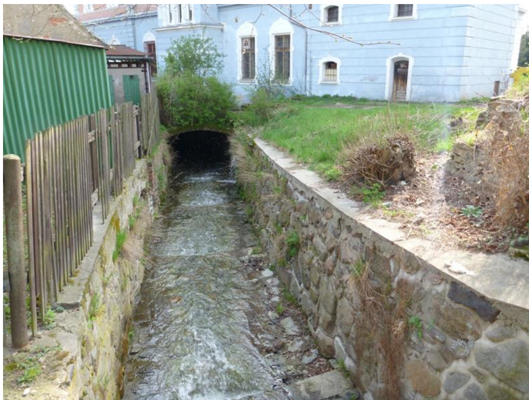
obr. č. 32 Jiřetínský potok protékající zakrytým korytem – směr po proudu toku (Šíma 2014).
