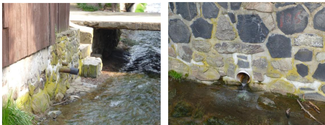
obr. č. 55, 56 Výpustě do vodoteče z okolních domů a zahrad (Šíma 2014).
