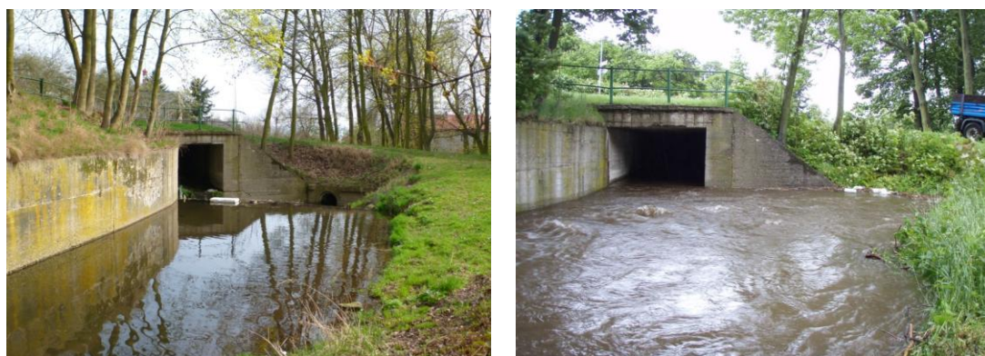
obr. č. 48, 49 Rozdělovací objekt při normálních a zvýšených průtocích vodoteče (Šíma 2014; 2013).
