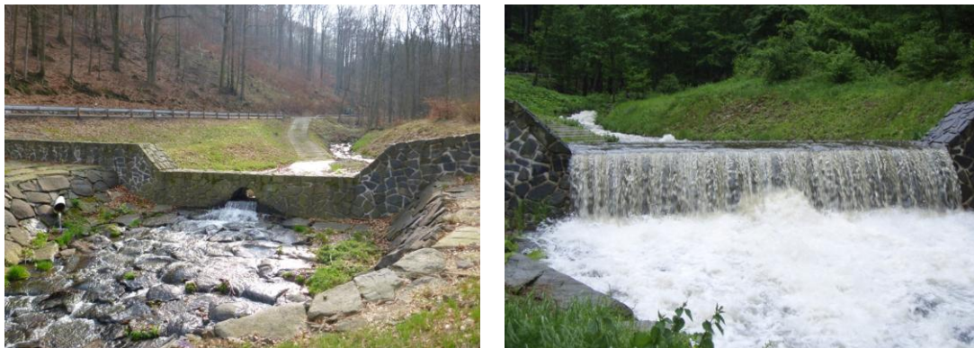
obr. č. 50, 51 Štěrková přehrážka – náhled zespoda, proti proudu vodního toku (Šíma 2014; 2013).
