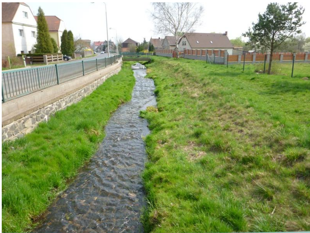
obr. č. 30 Jiřetínský potok v úseku ř. km 0,262 až 0,689 – směr po proudu toku (Šíma 2014).
