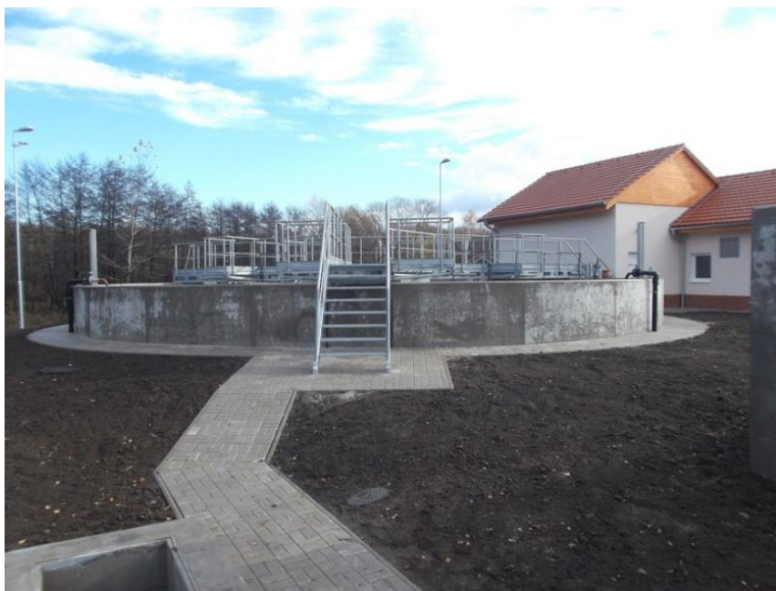
obr. č. 67 Čistička odpadních vod před dokončením (Horní Jiřetín 2014).
