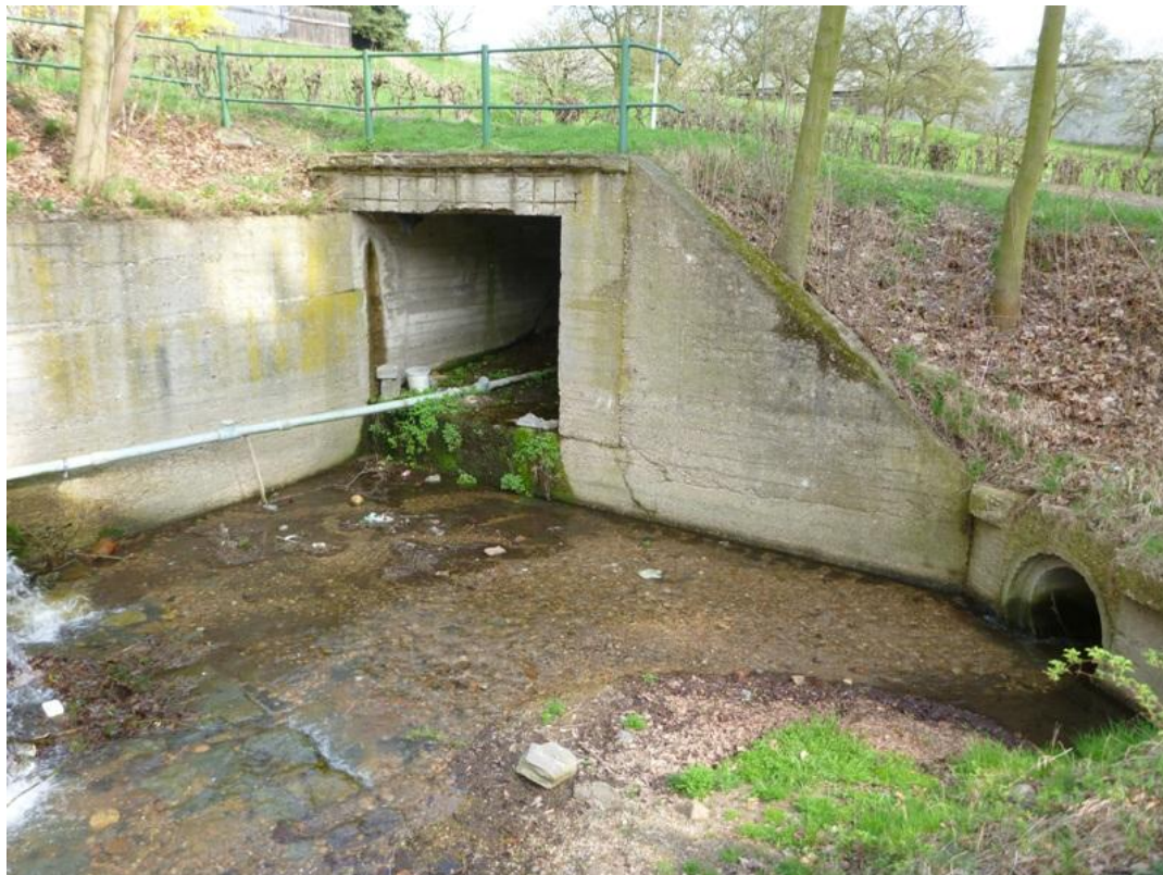
obr. č. 35 Rozdělovací objekt sloužící k ochraně města při povodňových průtocích (Šíma 2014).
