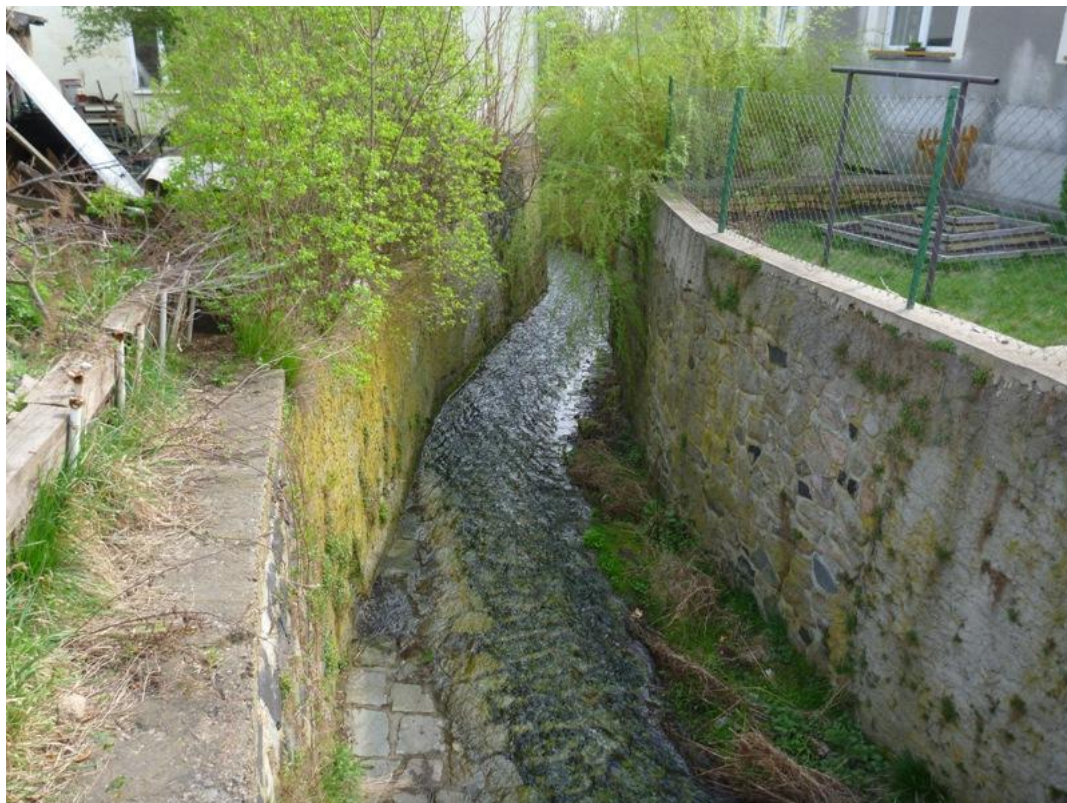
obr. č. 36 Jiřetínský potok v úseku ř. km 1,731 až 2,502 – směr po proudu toku (Šíma 2014).
