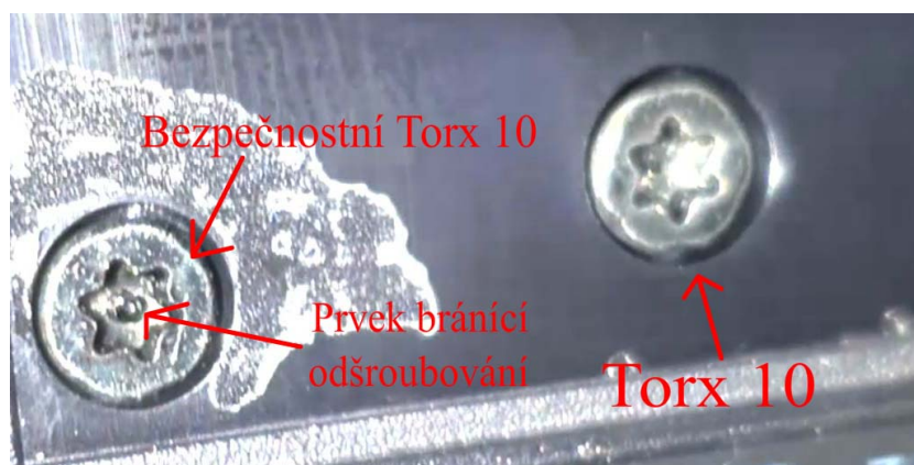
Obrázek 35: Klasický Torx 10 vs. bezpečnostní Torx 10
