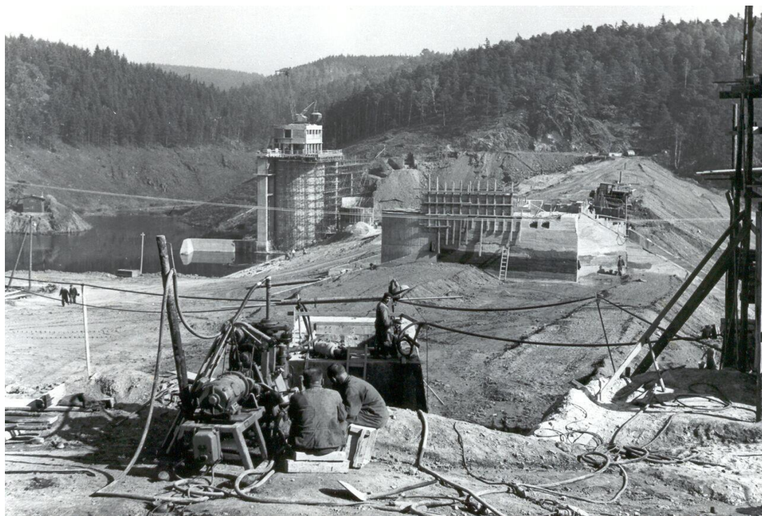
Obrázek 5. Dokončovací práce na hrázi přehrady (zdroj: archiv Povodí Vltavy s. p.)
