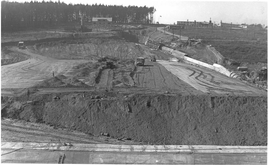
Obrázek 3. Zahájení sypání hráze (zdroj: archiv Povodí Vltavy s. p.)
