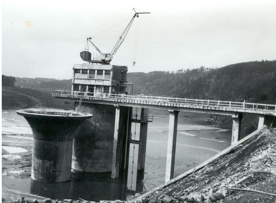
Obrázek 6. Kašnový přeliv před dokončením (zdroj: archiv Povodí Vltavy s. p.)
