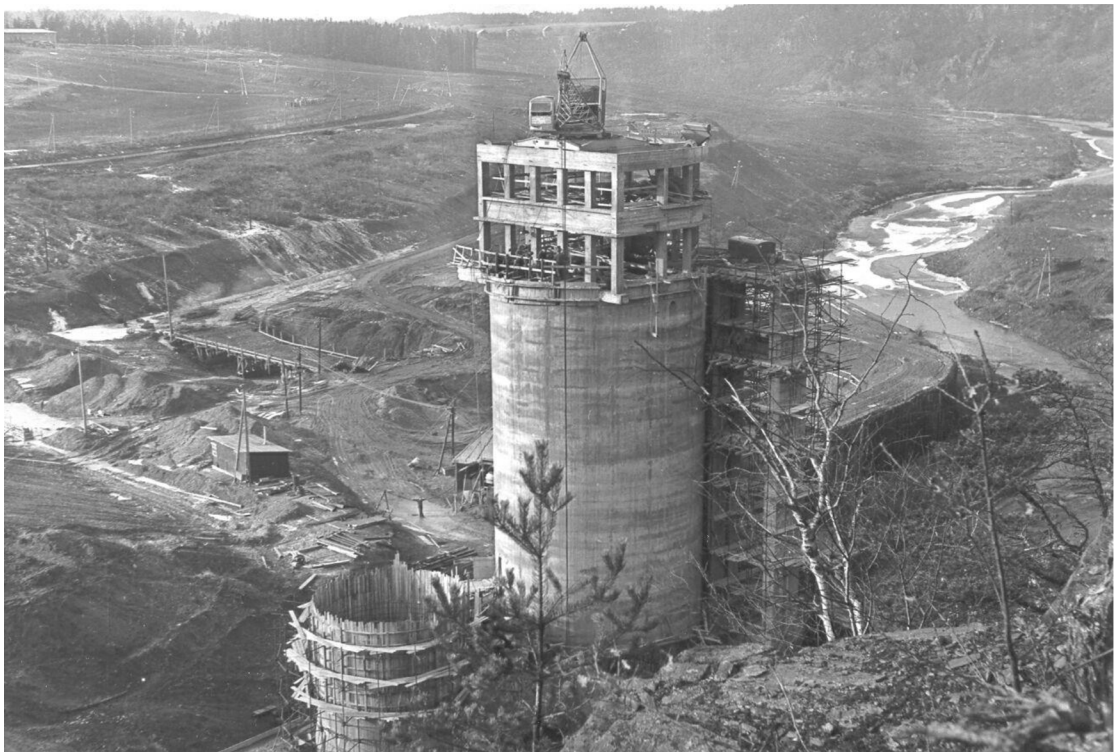
Obrázek 4. Stavba kašnového přelivu (zdroj: archiv Povodí Vltavy s. p.)
