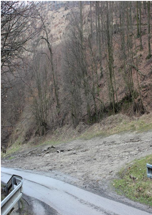
Obr.42 Lesný sklad pohľad 1/2.
