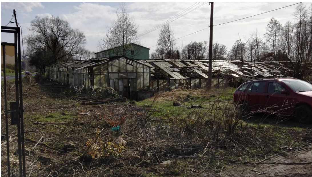
Foto č. 14 Ostrov – původní využití zahradnictví, současnost - probíhá demolice (Neckářová, 2016)
