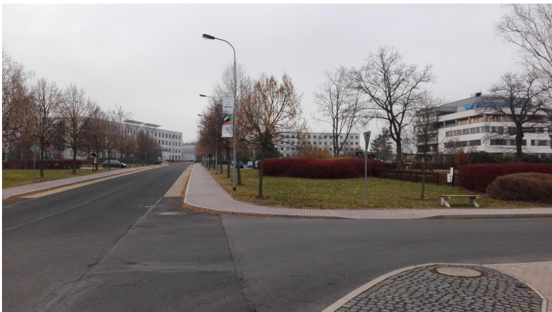
Obr. č. 14: Areál s hlavními zrekonstruovanými budovami Krajského úřadu Karlovarského kraje Zdroj: Neckářová, 2016
