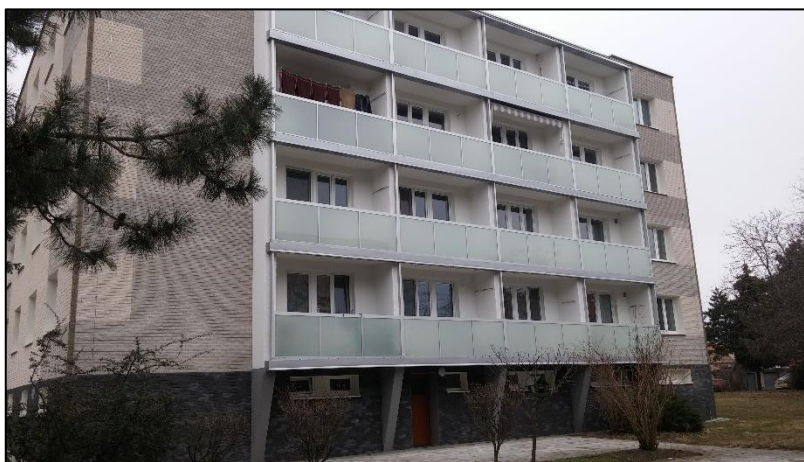
Obr. č. 22 - Bytový dům s bytem č. 6 [vlastní]
