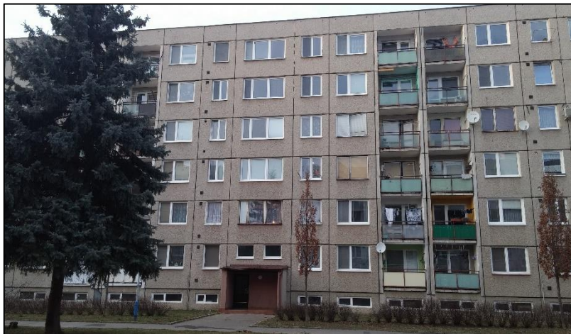
Obr. č. 7 – Bytový dům s bytem č. 1 [vlastní]
