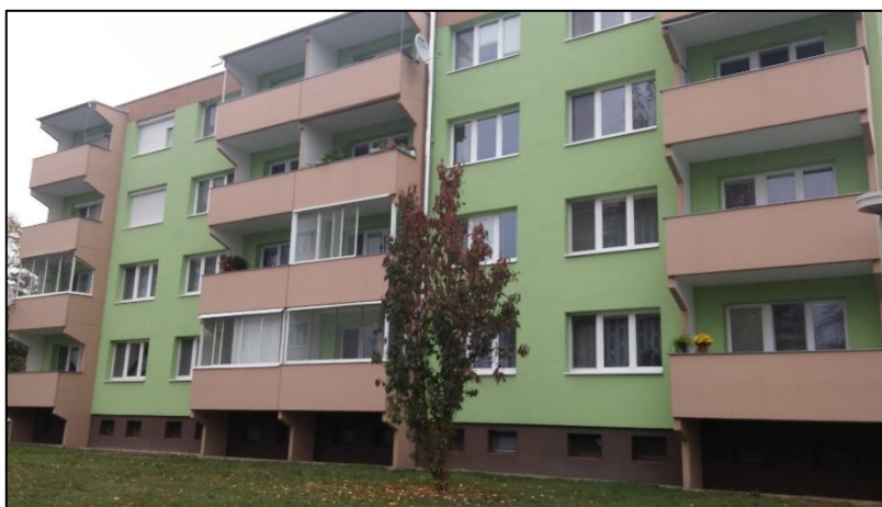
Obr. č. 16 – Bytový dům s bytem č. 4 [vlastní]
