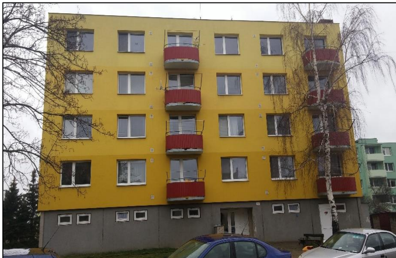
Obr. č. 13 – Bytový dům s bytem č. 3 [vlastní]
