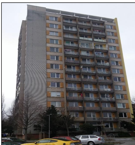
Obr. č. 19 - Bytový dům s bytem č. 5 [vlastní]
