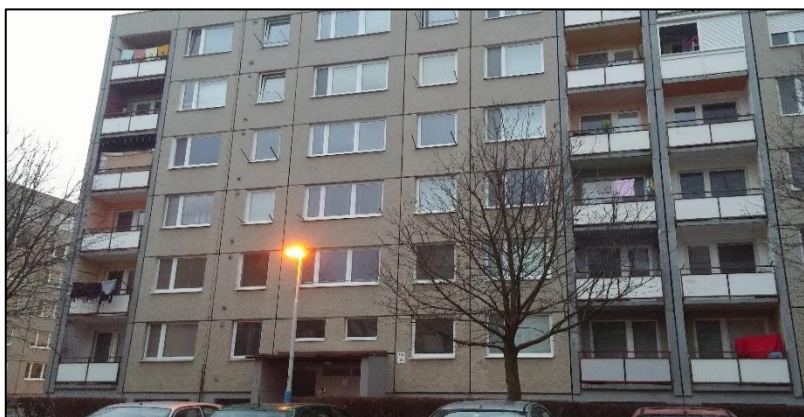
Obr. č. 10 – Bytový dům s bytem č. 2 [vlastní]
