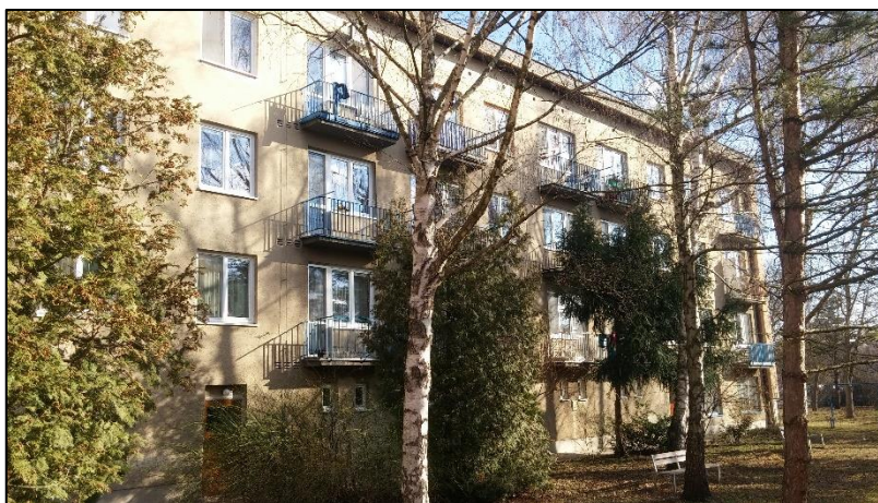
Obr. č. 25 - Bytový dům s bytem č. 7 a 8 [vlastní]
