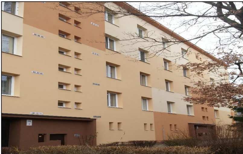
Obr. č. 32 – Bytový dům s bytem č. 10 [vlastní]
