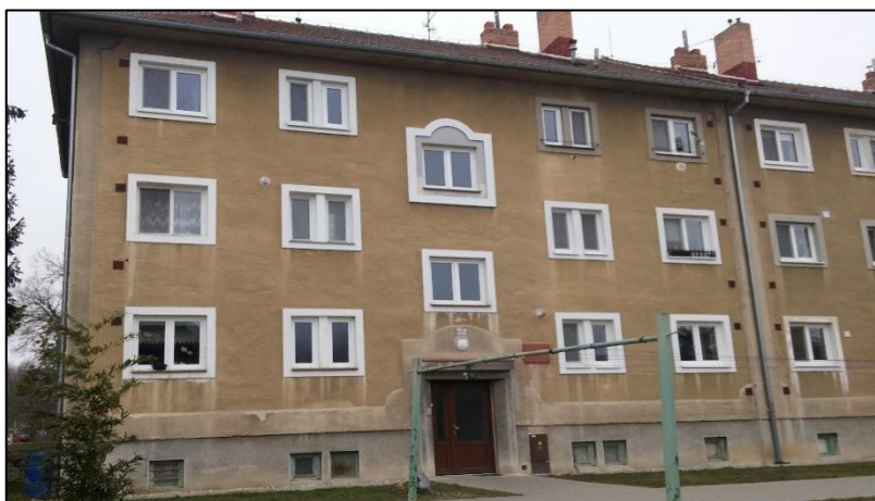
Obr. č. 29 – Bytový dům s bytem č. 9 [vlastní]
