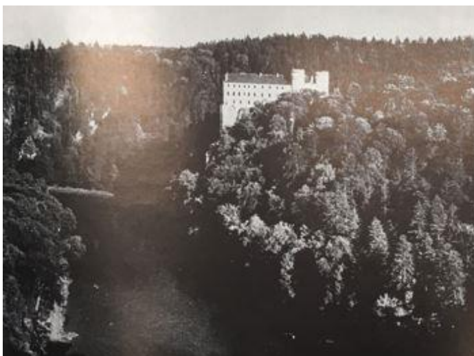
Obr. 32: Hrad Orlik před napuštěním nádrže (Podzimek & kol., 1970).
