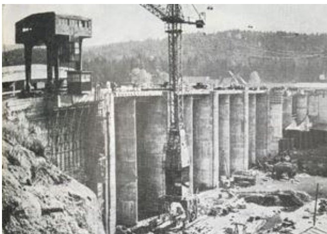
Obr. 27: Výstavba přehrady Kamýk (Hašková, 1961).
