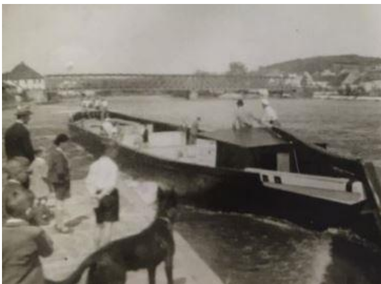
Obr. 20: První vorová propust v Týně nad Vltavou (Šílený & kol., 2013).
