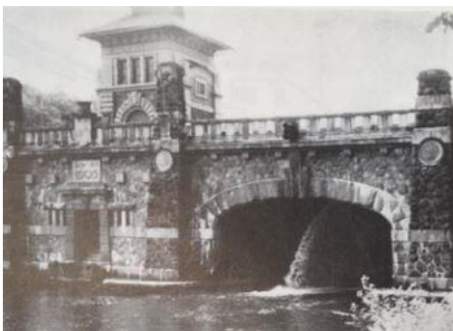
Obr. 28: Plavební komory v Hoříně (Podzimek & kol., 1970).
