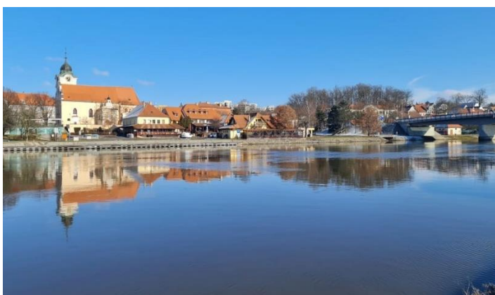
Obr. 6: Pohled na říční koryto bez jezů a na betonový most v Týně nad Vltavou roku 2021 (autor: vlastní terénní šetření, 2021).
