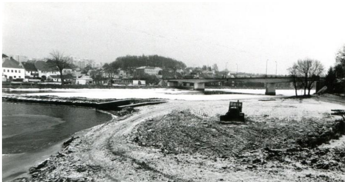
Obr. 4: Pohled na betonový most při bourání jezů v letech 1989-1990 v Týně nad Vltavou („nepublikováno“. Dep.: Městské muzeum Týn nad Vltavou, archiv).
