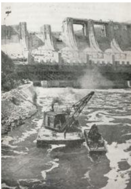
Obr. 26: Pohled na výstavbu přehrady Slapy (Hašková, 1961).
