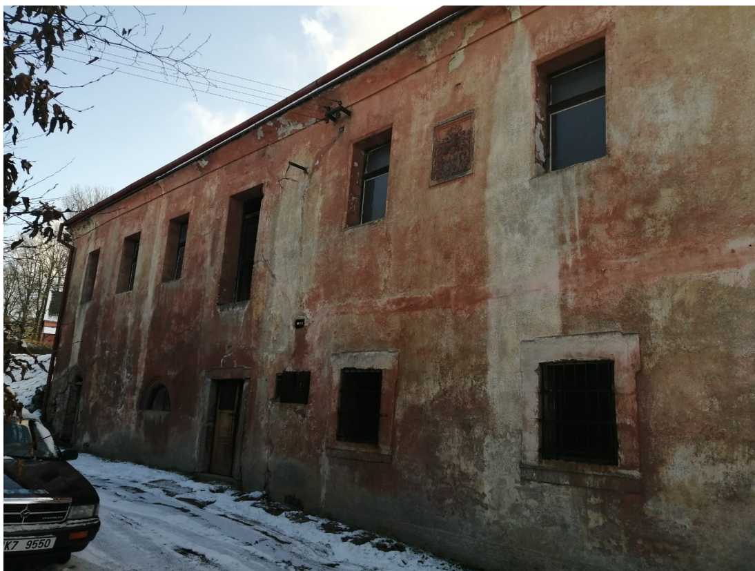
Obrázek 16: Pohled na východní stranu tvrze a vchod (foto autor)
