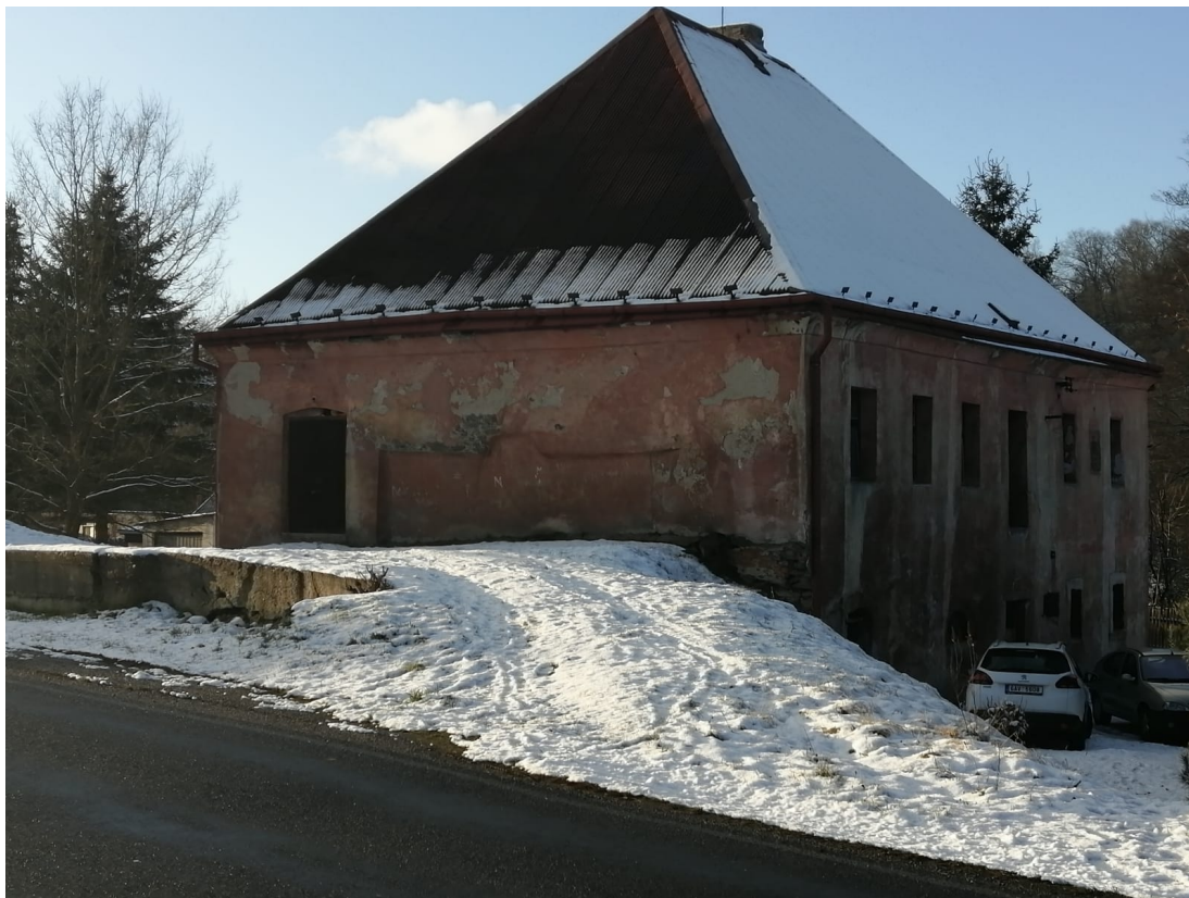
Obrázek 18: Vstup do 1. patra po části zasypaného sklepa (foto autor)
