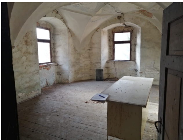
Obrázek 23: Budoucí ubytovací prostor se sociálním zařízením (foto autor)
