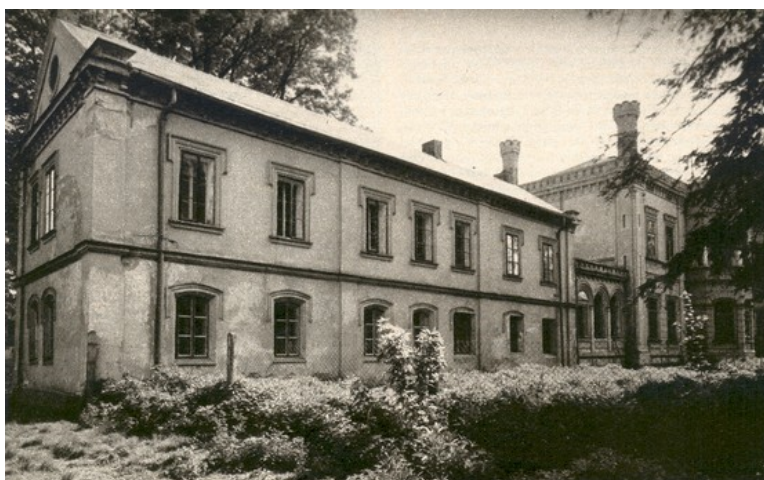
Obrázek 5: Zámek Mostov před rekonstrukcí (Nechvátal, 1985) (URL 5)
