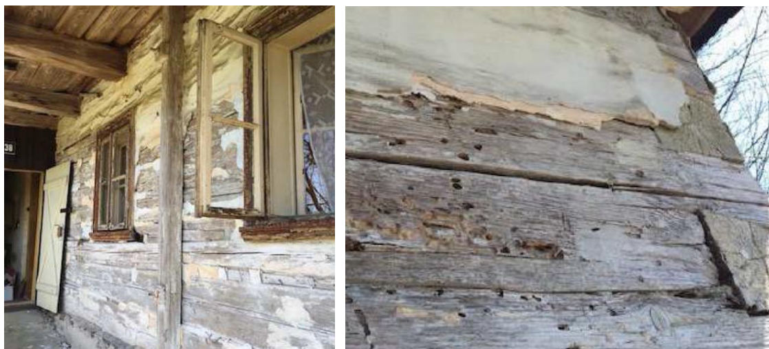
Obr. 46 Stěna č. 1 se dvěma okenními otvory, detail omítky (foto vlastní, 2016)
