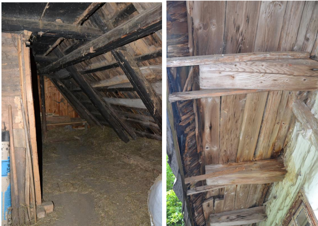
Obr. 67 Vlevo pohled do podstřešního prostoru, vpravo je vidět přesah střešní konstrukce u vstupu do objektu, pohled na stropní nosné trámy (foto vlastní, 2015)
