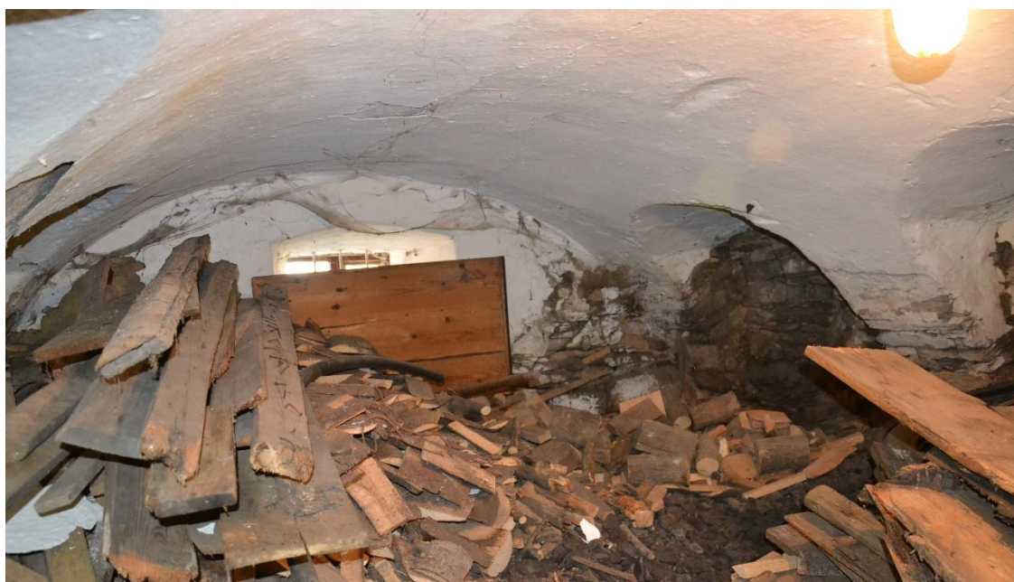
Obr. 38 Valená klenba s lunetami ve chlévě (foto vlastní, 2015)
