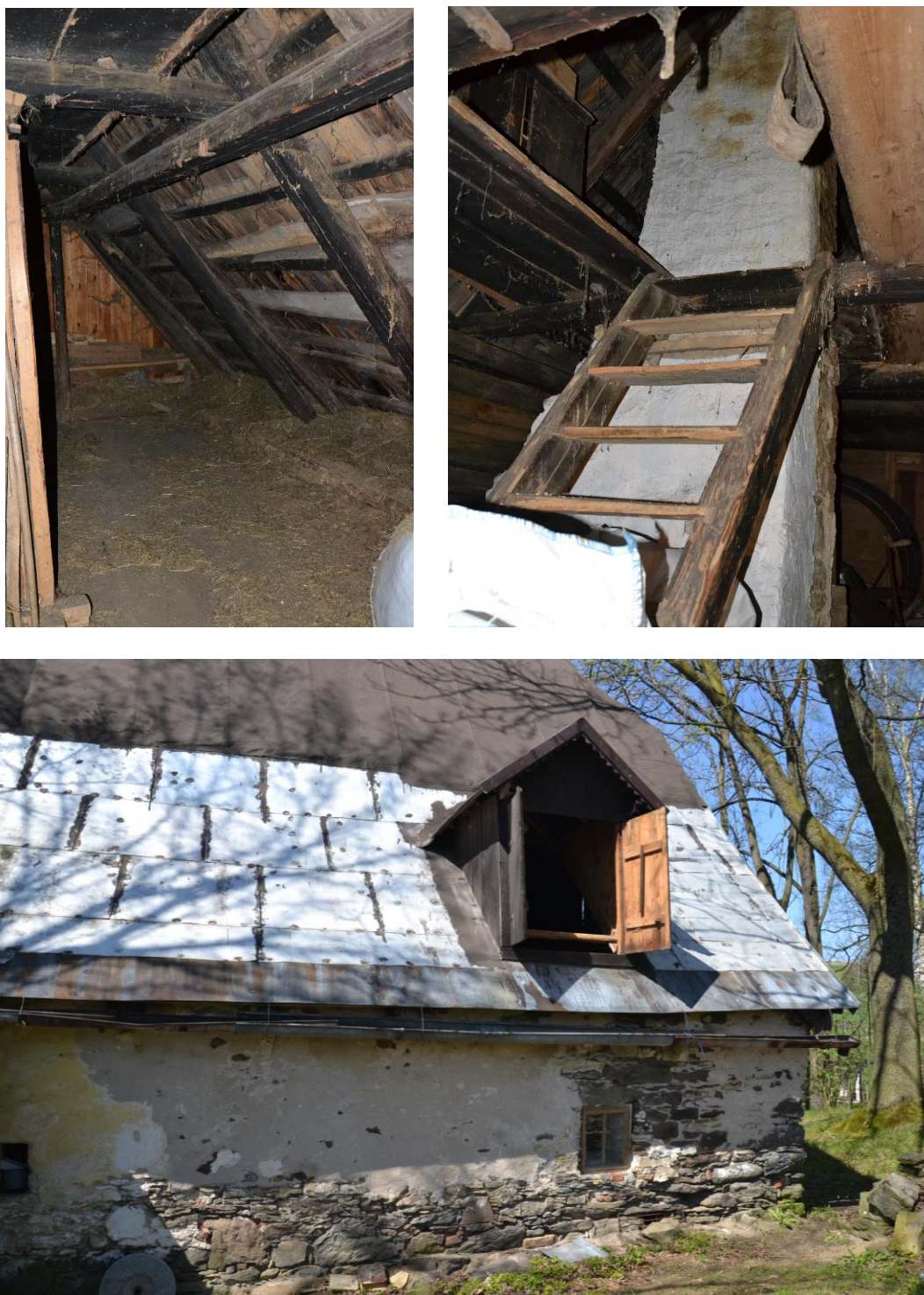
Obr. 43 Vlevo nahoře konstrukce krovu a střechy, vpravo nahoře schody do druhého půdního patra a komín, dole vikýř na východní straně stavení (foto vlastní, 2016)
