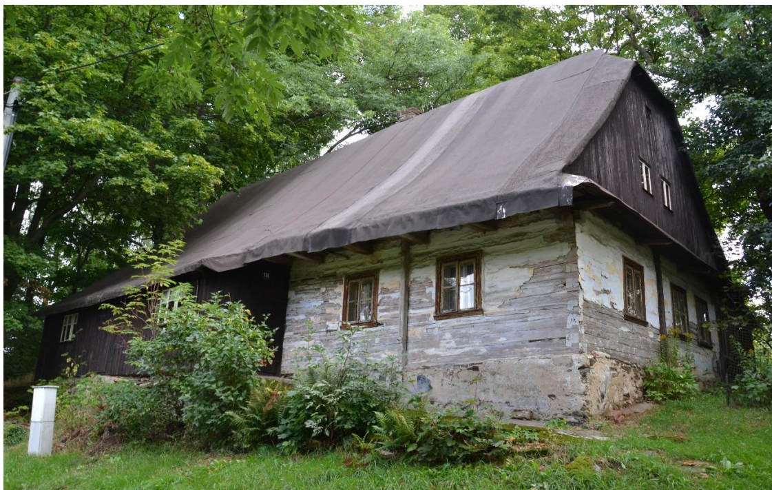
Obr. 31 Pohled na jihozápadní část domu (foto vlastní, 2015)
