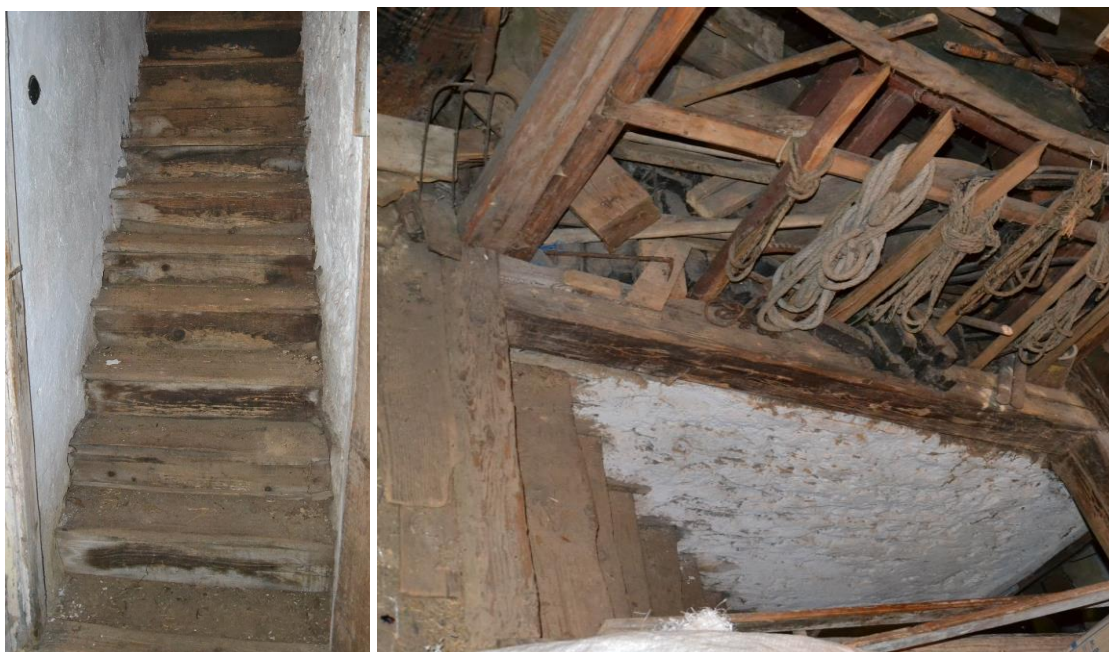
Obr. 54 Schodiště z přízemí na půdu, detail u výstupního stupně (foto vlastní, 2015)
