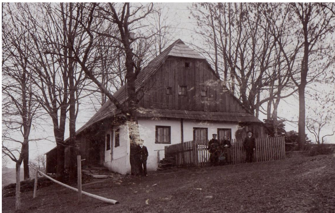
Obr. 32 Stav objektu z roku 1912 (fotoarchiv majitele)
