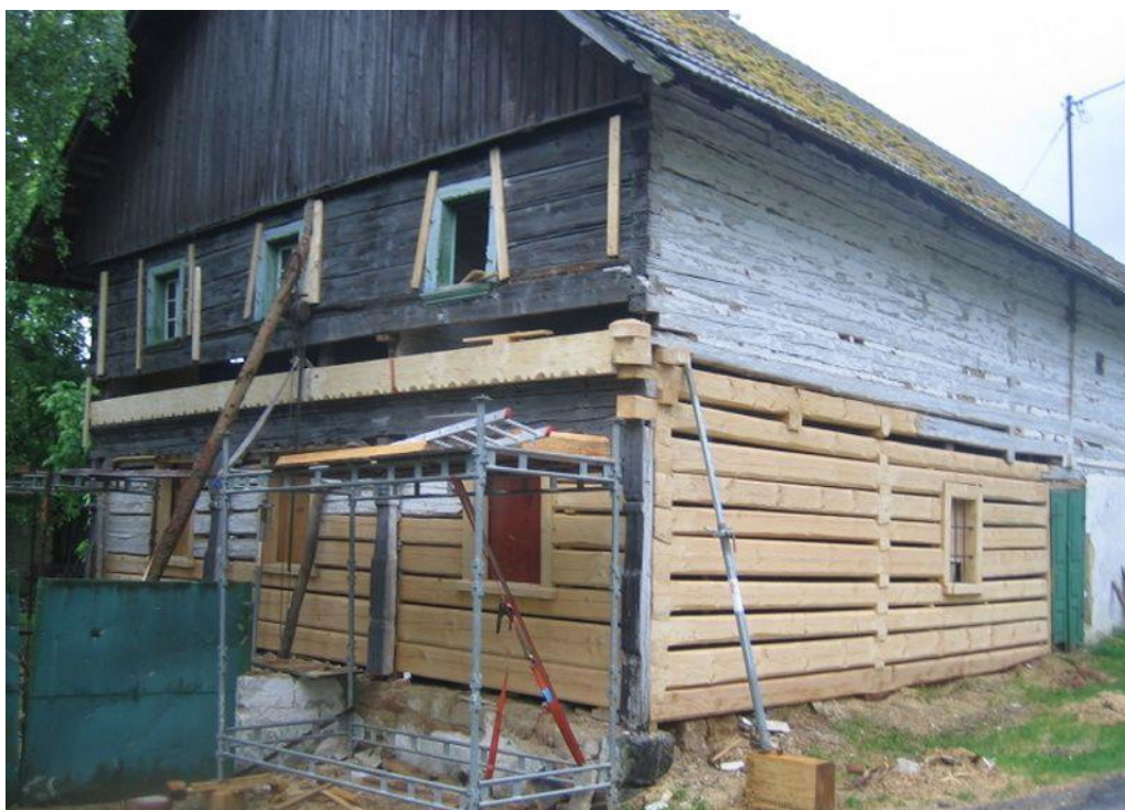
Obr. 27 Rekonstrukce roubenky – pohled na obvodové stěny objektu
