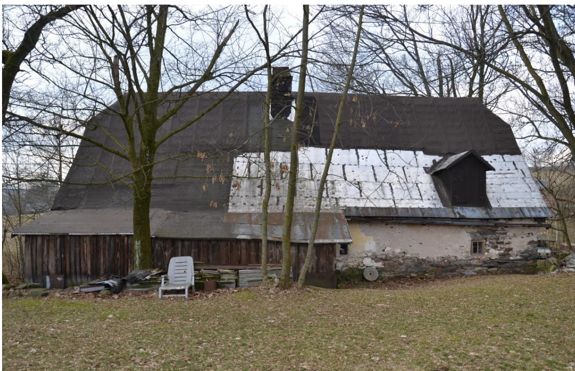
Obr. 61 Pohled na střešní rovinu s krytinou asfaltovou i plechovou (foto vlastní, 2016)
