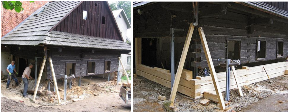
Obr. 26 Výměna trámů roubené stěny a její statické zajištění ( http://www.tesarcep.cz/rekonstrukce-roubenych-staveb/ , 2016)
