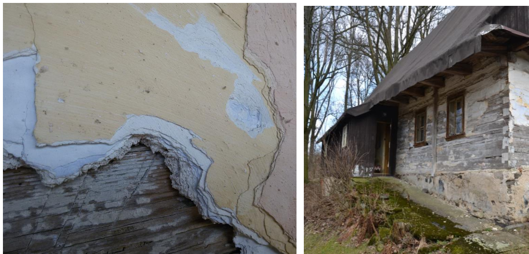
Obr. 45 Detail venkovní omítky a pohled na stěnu č. 1 (foto vlastní, 2016)
