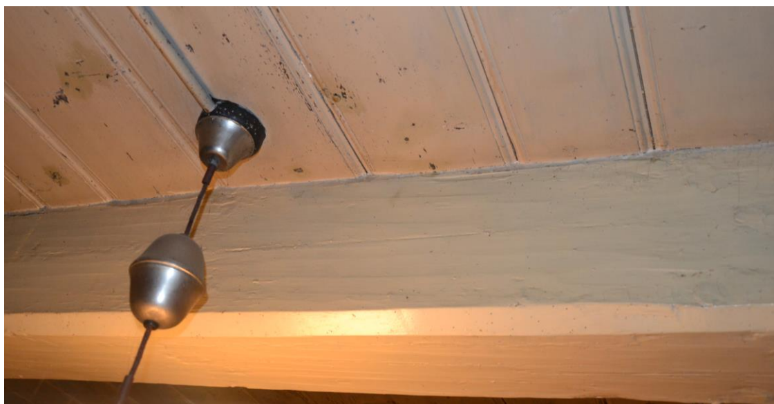
Obr. 41 Detail stropu (foto vlastní, 2015)
