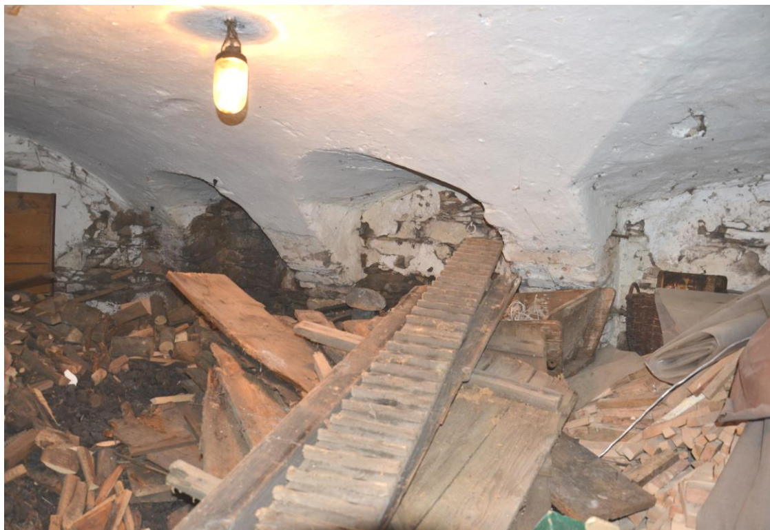
Obr. 57 Klenutý strop ve chlévě, nevykazující žádné poruchy (foto vlastní, 2015)
