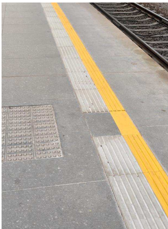
Obr. 29 – Realizace vodící linie s funkcí varovného pásu
