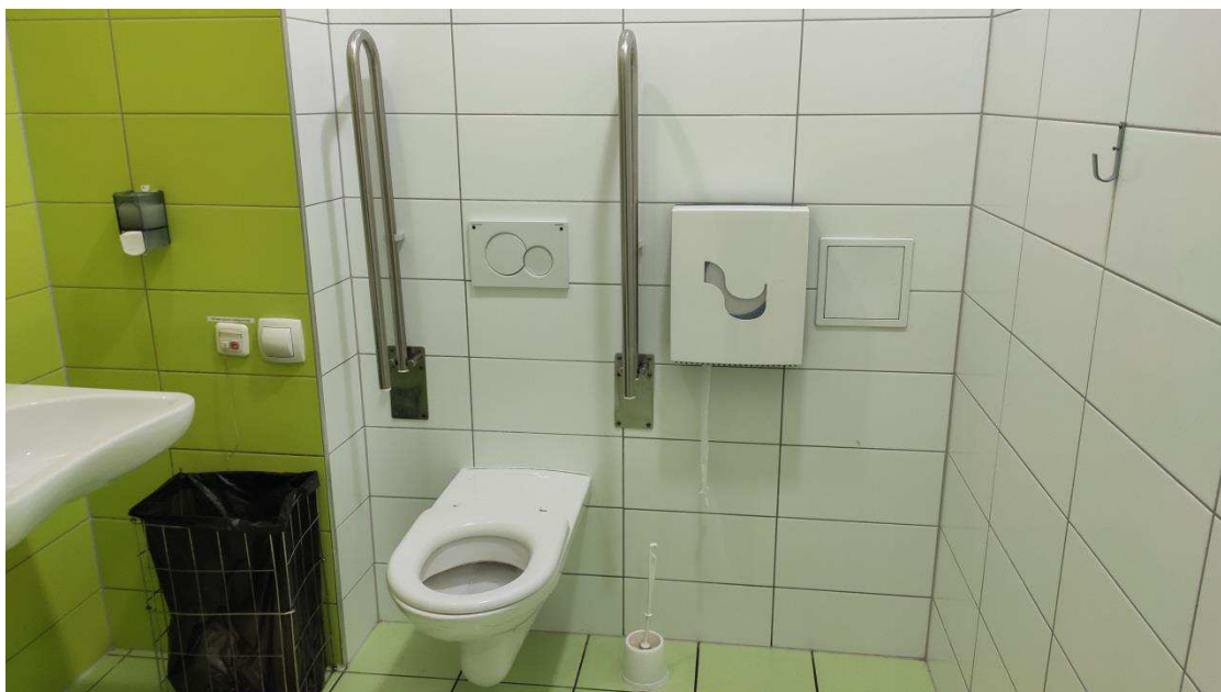
Obr. 34 – Místnost toalety se zařizovacími předměty
