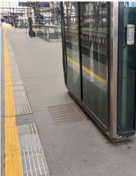
Obr. 32 – Výtah a) Signální pás k výtahu; b) ovládací panel výtahu
