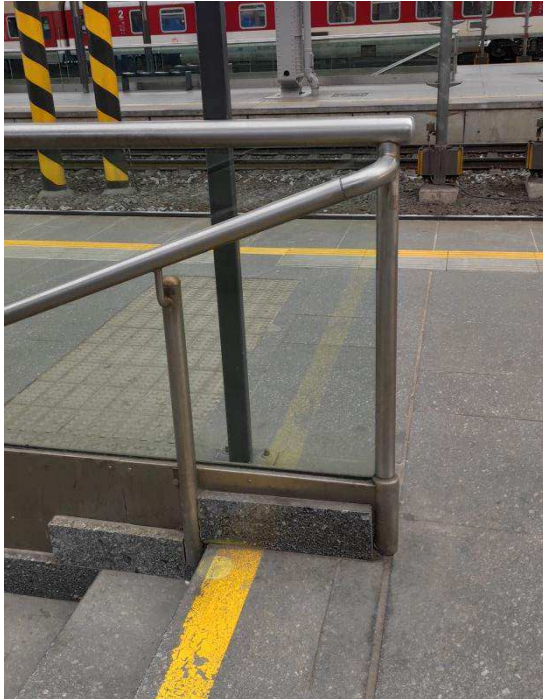
Obr. 31 – Nástupiště a) Provedení madla; b) akustický majáček nad schodištěm
