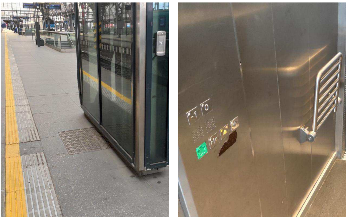
Obr. 32 – Výtah a) Signální pás k výtahu; b) ovládací panel výtahu
