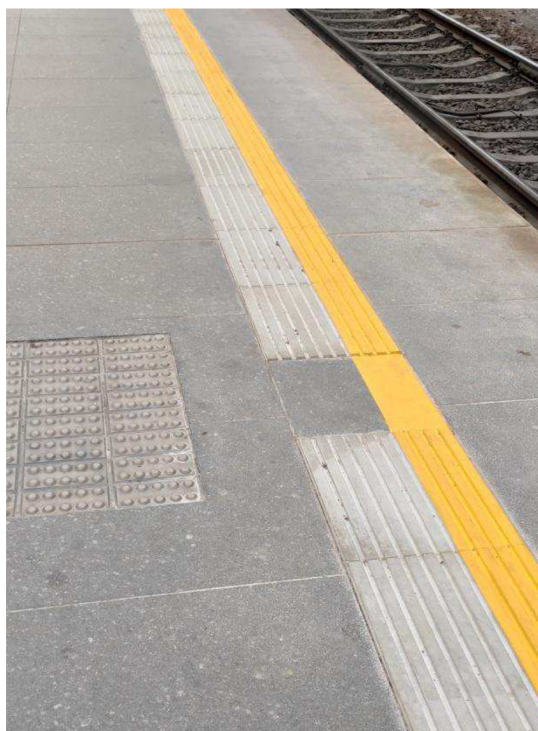
Obr. 29 – Realizace vodící linie s funkcí varovného pásu
