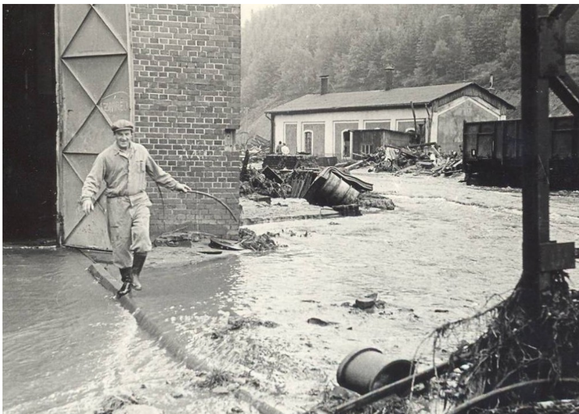
Zatopená vnitřní část bývalých jatek v Kraslicích. Zdroj: www.rotava , 2018
