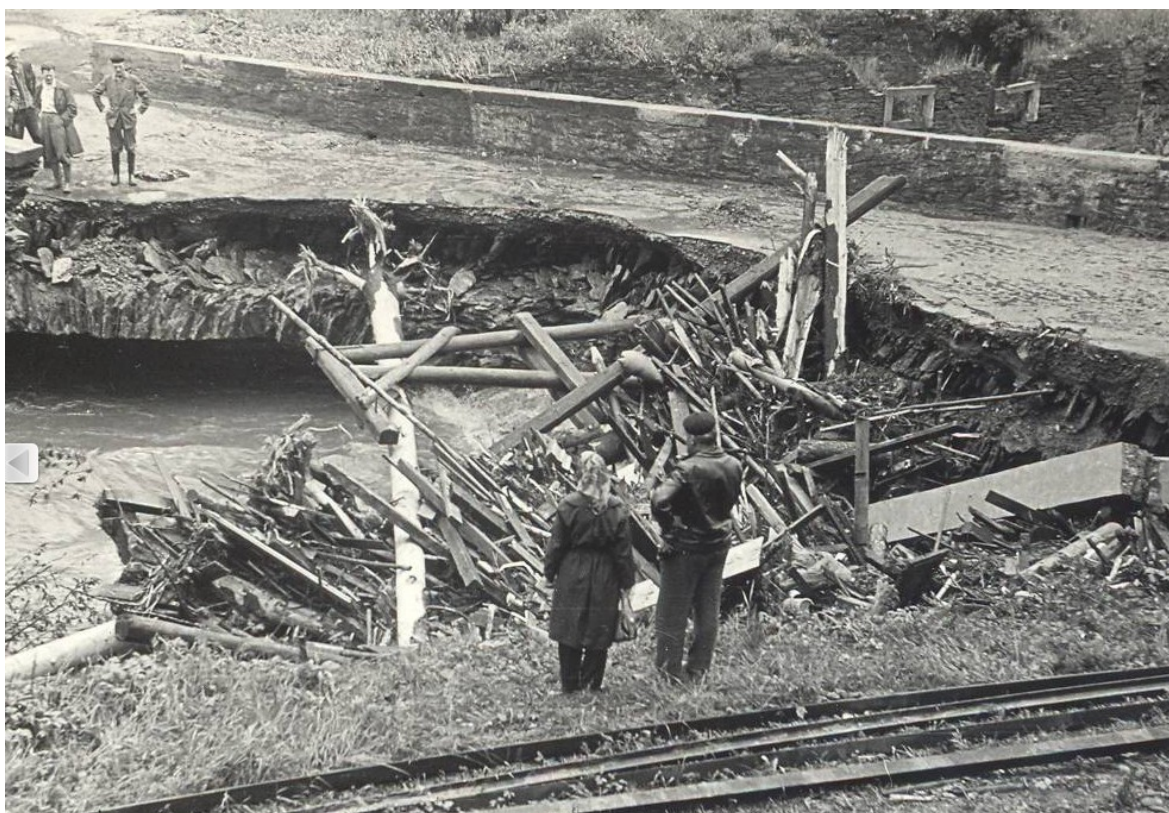
Zakleštěný most v obci Šindelová. Zdroj: www.rotava , 2018
