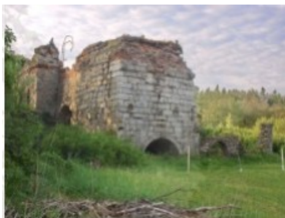
Obrázek 23: Hut' v Šindelové před zahájením záchranných prací r. 2015 (URL 23)
