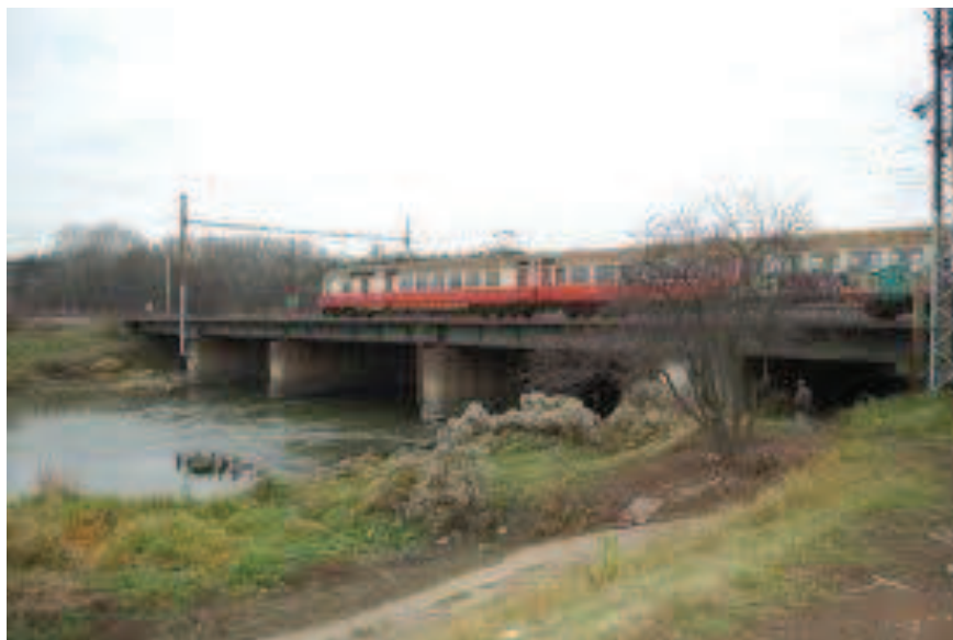
Obr. č. 2. 1 – sledovaný most před rekonstrukcí [1]
