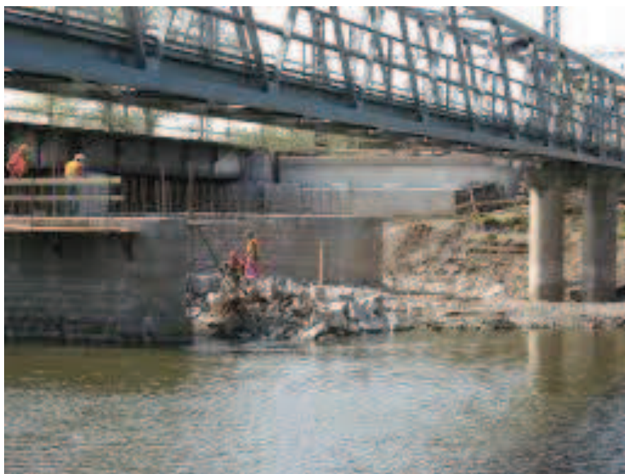
Obr. č. 2. 2 – sledovaný most v době rekonstrukce [1]
