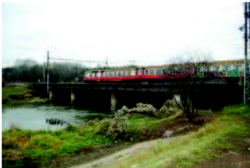
Obr. č. 2. 1 – sledovaný most před rekonstrukcí [1]
