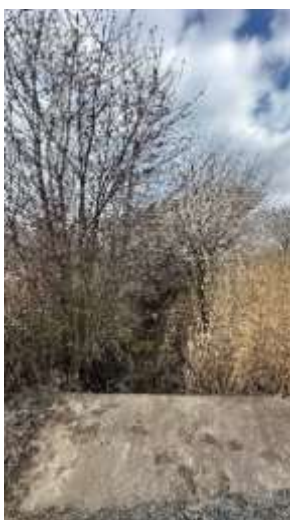
Obrázek 54 - Propustek na cestě HPC 5 a biokoridor LBK 10 (Dokoupilová, 2024)
