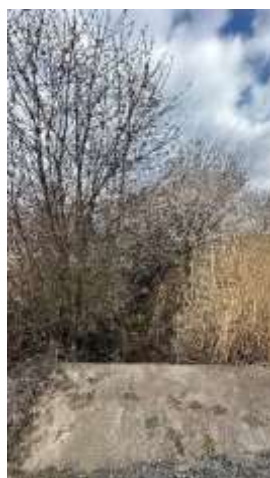
Obrázek 48 - Propustek na cestě VPCS 4 Sibřina (Dokoupilová, 2024)
