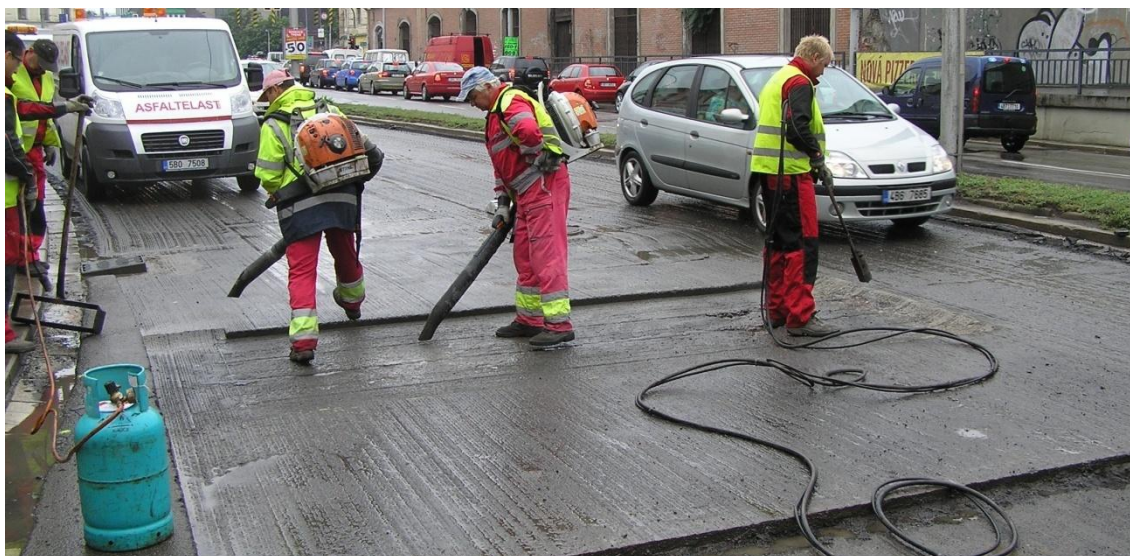
Obrázek 70: Vysoušení a nahřívání zářezů před aplikací SAMI
