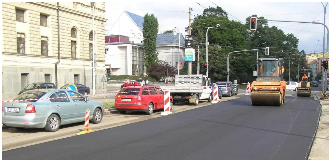
Obrázek 74: Hutnění vrstvy SAL dvěma hutnícími válci
