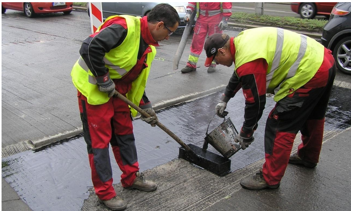
Obrázek 71: Rozprostření vrstvy SAMI
