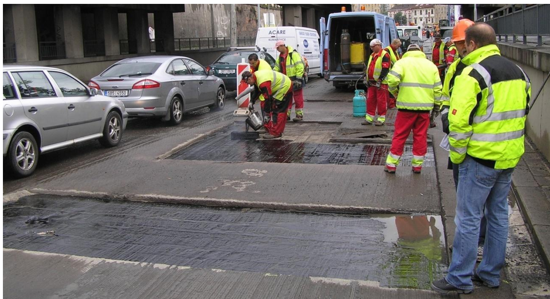
Obrázek 72: Průběh prací při aplikaci vrstvy SAMI
