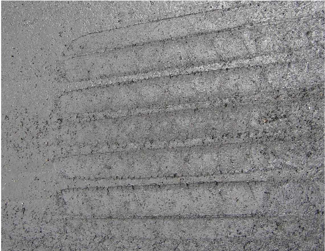
Obrázek 76: Vyjeté stopy ve spojovacím postřiku při dlouhodobém stání na vrstvě o teplotě 50 °C
