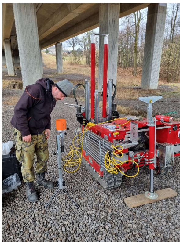
Obrázok č. 4.3: Príprava na skúšku pri mostnom objekte C203
