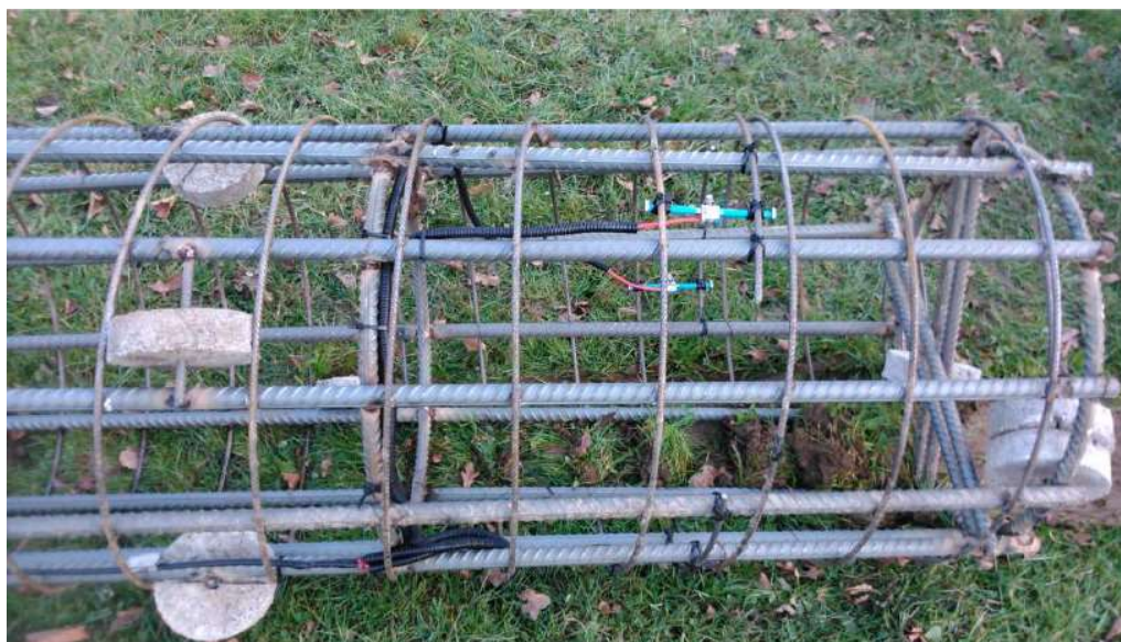
Obrázok č. 3.5: Inštalácia strunových tenzometrov na armokôš pilóty ( Masopust (17) )
