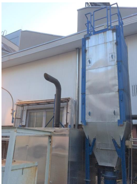
Obr. 5 Rukávcový filtr sloužící k zachytávání prachových částic ve spalínách
