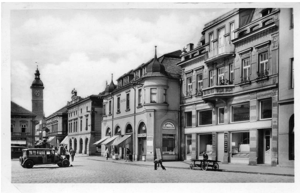
Obrázek 24: Domy Stanclovy lékárny a Hotelu Slunce po stavebních úpravách. U lékárny se změnil vstupní portály na kamenné a hotel Čáp byl celý přestavěn. Přírůstek podkrovní se projevil střešními vikýři na střeše hotelu
