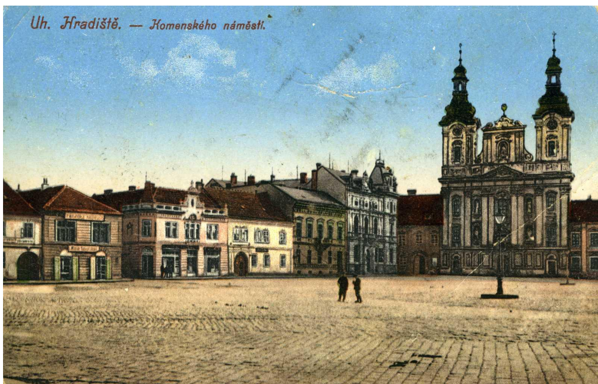
Obrázek 19: Jihozápadní roh Masarykova náměstí na přelomu prvního a druhého desetiletí. Již je postavena budova radnice i měšťanský dům čp. 259
