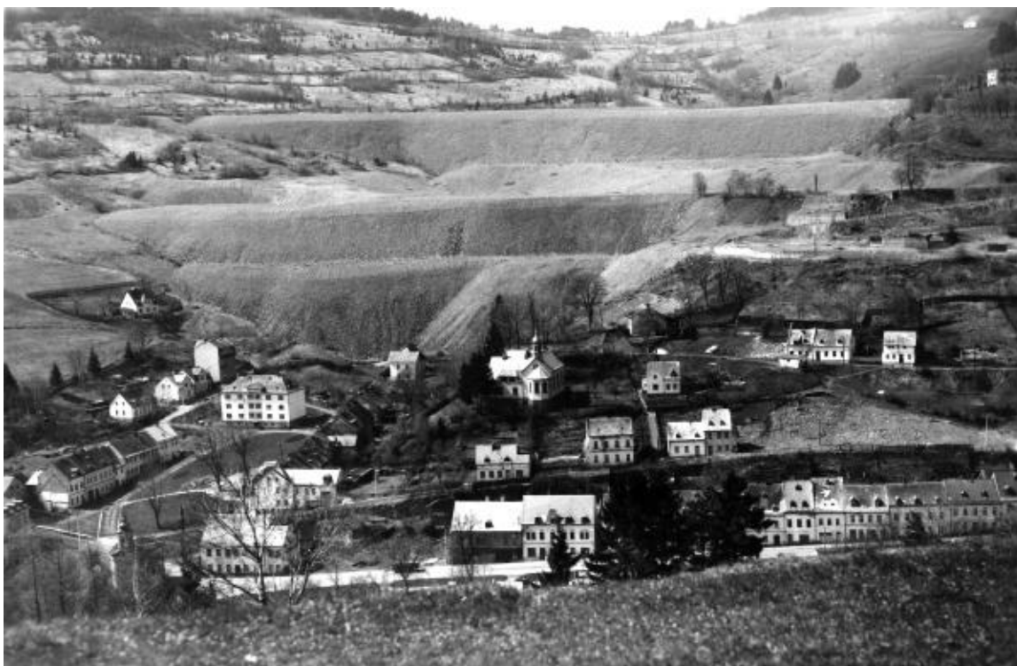
Obr. č. 19 Fotografie z 60. let. Stav stupňovité výsypky Na Slovanech, která zasypala horní část údolíčka. Pod ní zmizela i cesta na Popov a Mariánskou. Na zadním svahu je vidět pomalu zarůstající dříve obdělávaná pole (ZNKR, 2016)
