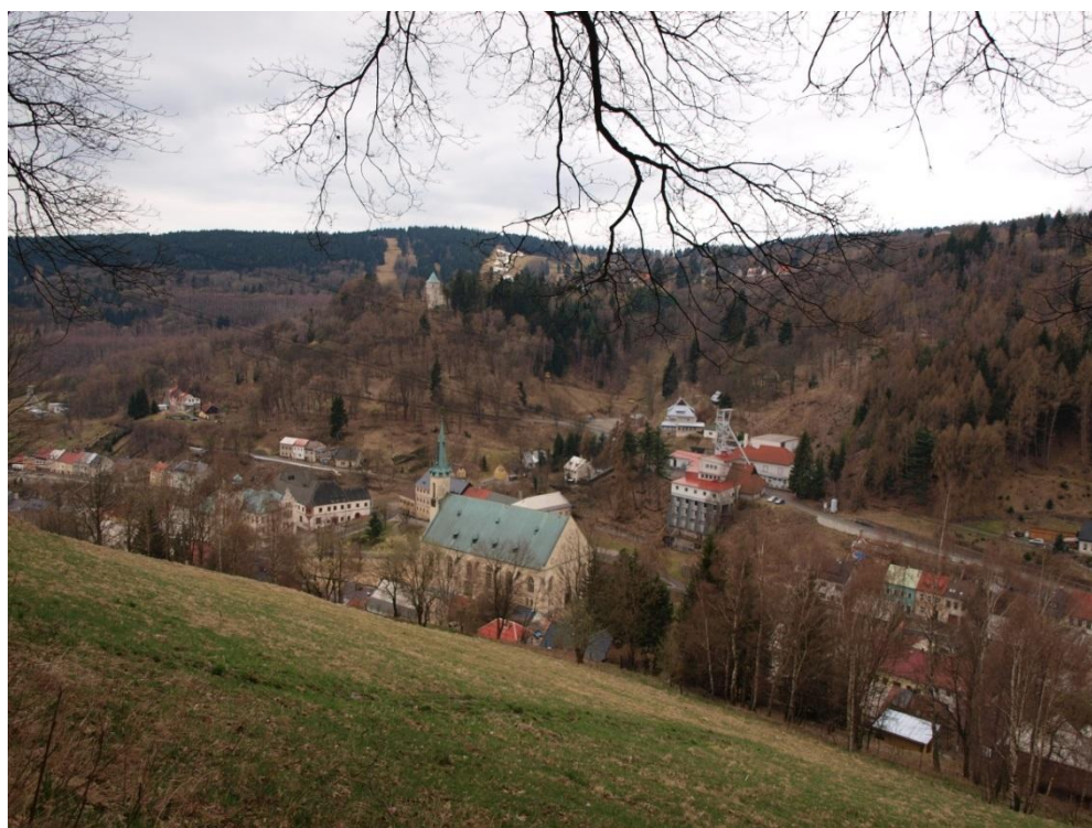
Obr. č. 26 Současná fotografie z podobného úhlu. Pod dolem Svornost (nyní s těžební věží) stávala měšťanská škola, zbořená během rozsáhlých demolic v 50. letech. Okolní stráně města jsou zarostlé smíšenými lesy (foto autor, 2016).
