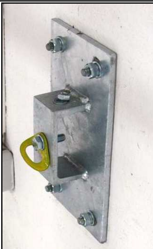
Obr. 6.8 Nový typ kotevního bodu pro kotvení u zdvihacího zařízení.
