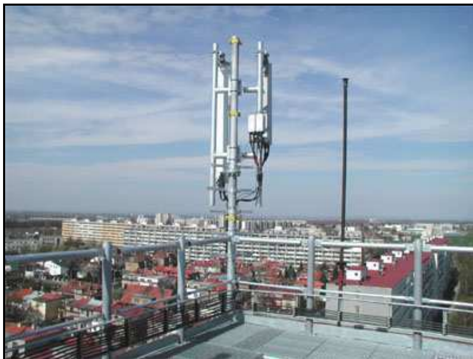
Obr. 3.5 Kolektivní bezpečnostní opatření (zábradlí).
