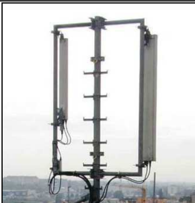
Obr. 6.11 Trubkový stožár se dvěma anténními výložníky
