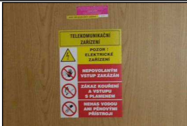
Obr. 3.12 Příklad značení vně dveří.
