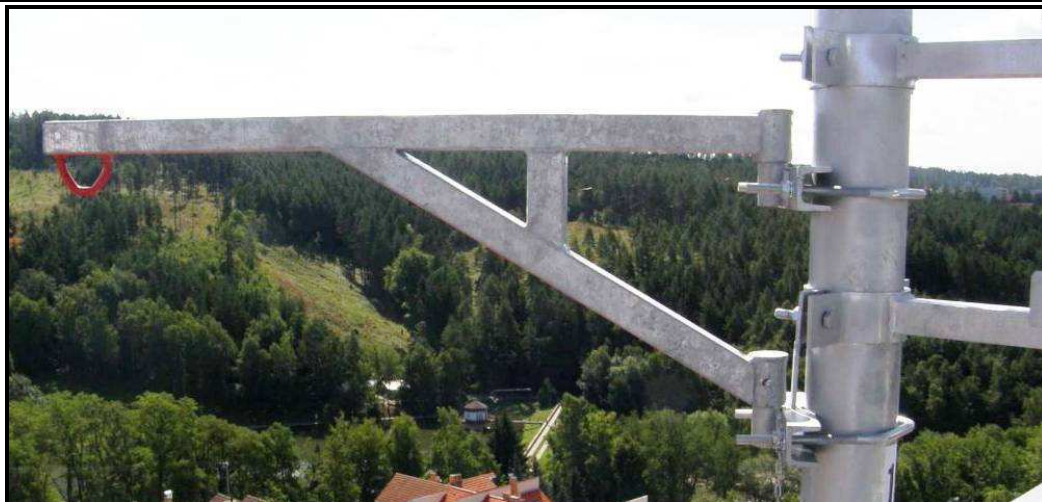
Obr. 6.9 Dříve používané zdvihací ústrojí.
