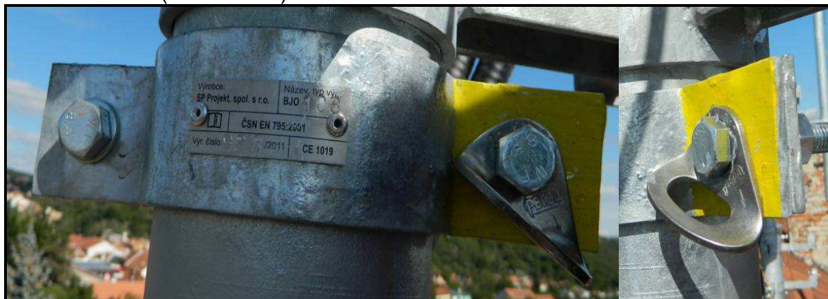
Obr. 6.5 Nový kotevní bod na stožáru.
