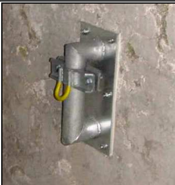
Obr. 6.7 Dříve užívaný kotevní bod pro kotvení u zdvihacího zařízení.
