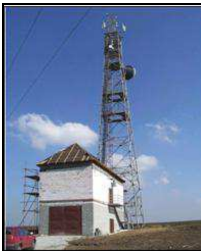
Obr. 4.5 Konstrukce telekomunikační věže.
