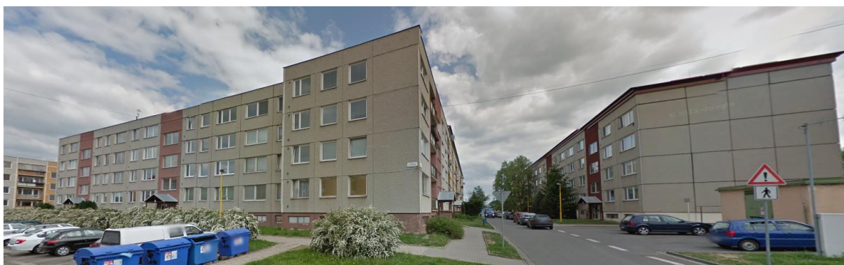
Obr. 14: Sídlíště Mařatic - Východ [zdroj: www.showmystreet.com ]
