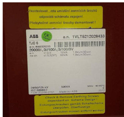
Obrázek 5 - Štítek přístrojového transformátoru napětí
