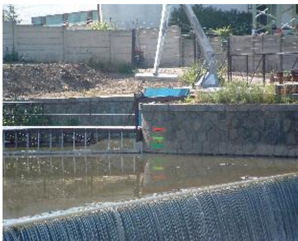
Obrázek č.3 Husovický jez (malá vodní elektrárna)
