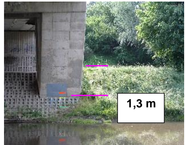
Obrázek č.2 Pilíř mostu Provazníkova
