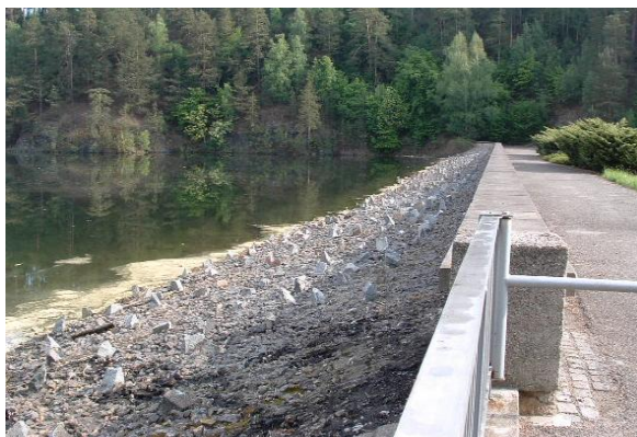
Obrázek č. 16: Vodní dílo Letovice Foto: autor DP
