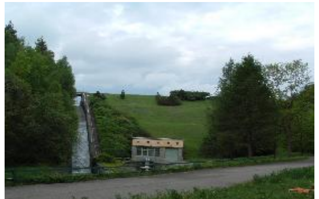
Obrázek č. 15: Vodní dílo Letovice Foto: autor DP
