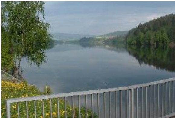
Obrázek č. 14: Vodní dílo Letovice Foto: autor DP
