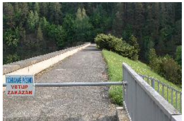
Obrázek č.17 : Vodní dílo Letovice Foto: autor DP
