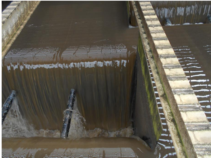
Obr. č. 13 - Společný odtokový žlab z lapáku písku (vlastní)
