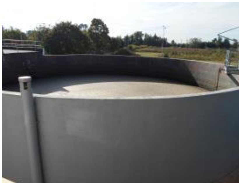
Obr. č. 7 - Uskladňovací nádrž na ČOV Prostějov (vlastní)
