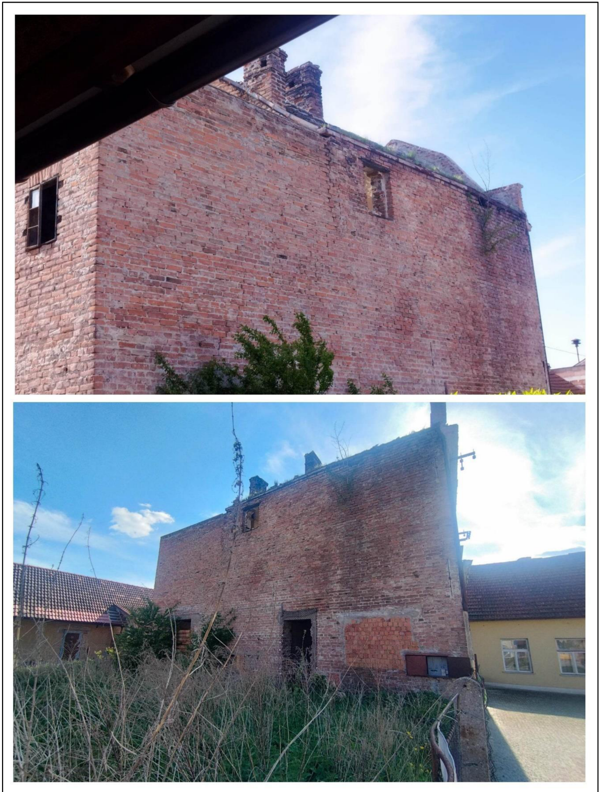
Obrázek 21: B5 – sklárna v Horním Jelení (zdroj: vlastní fotodokumentace)
