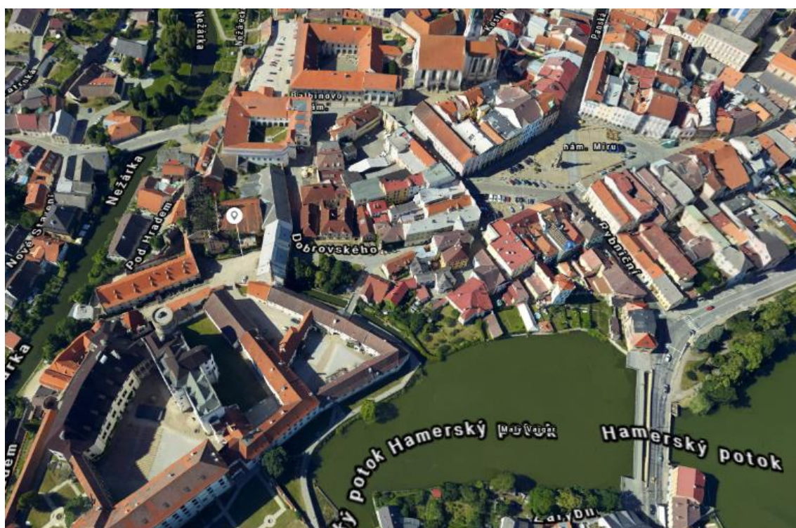
Obrázek 35: Křižíkova elektrárna v Jindřichově Hradci
