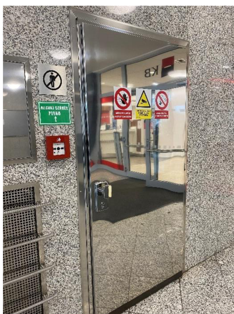
Obrázek 7 - zabezpečení budovy (Vlastní práce, 2023)
