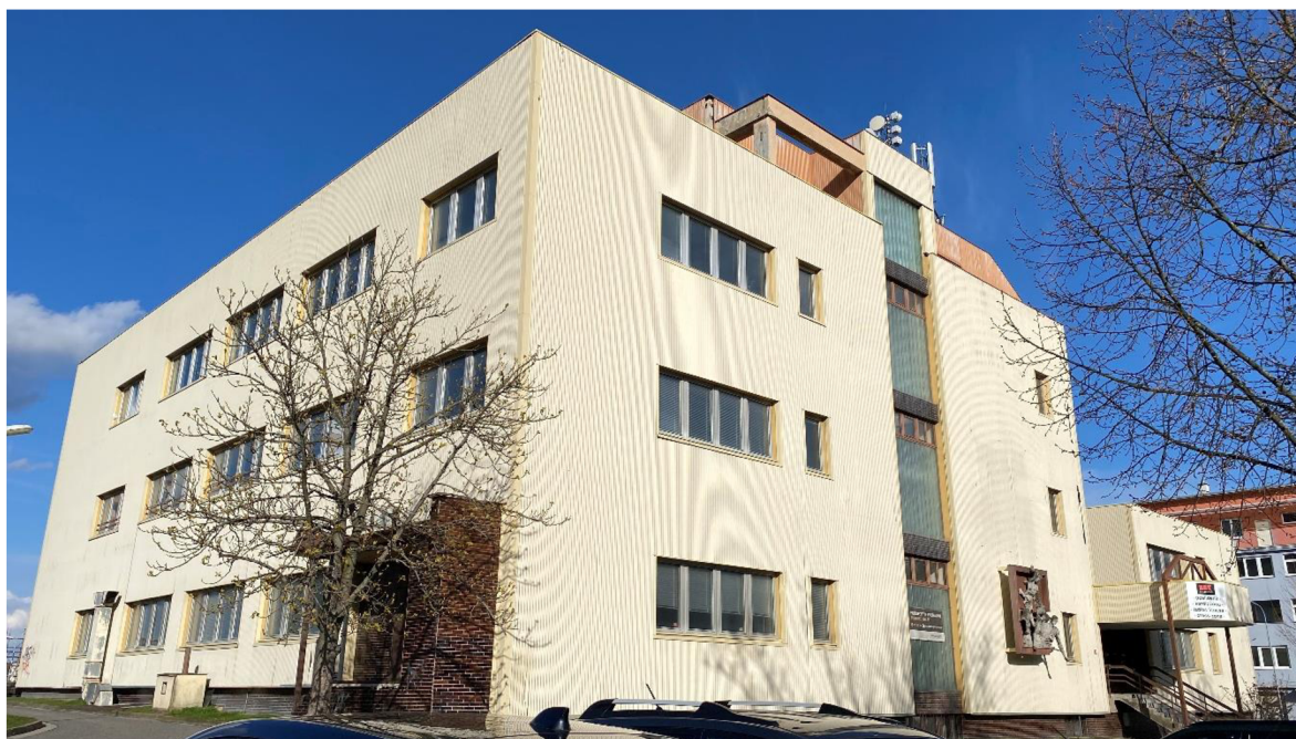
Obrázek 11 – budova Telecomu ve Znojmě (Vlastní práce, 2023)
