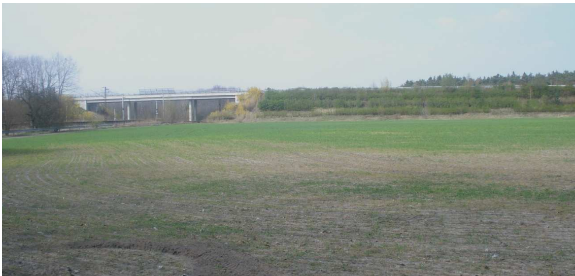
Obr. 8 Silniční násep v místě křížení silnice a železnice u Veltrub (Jiří Pospíšil, březen 2012)
