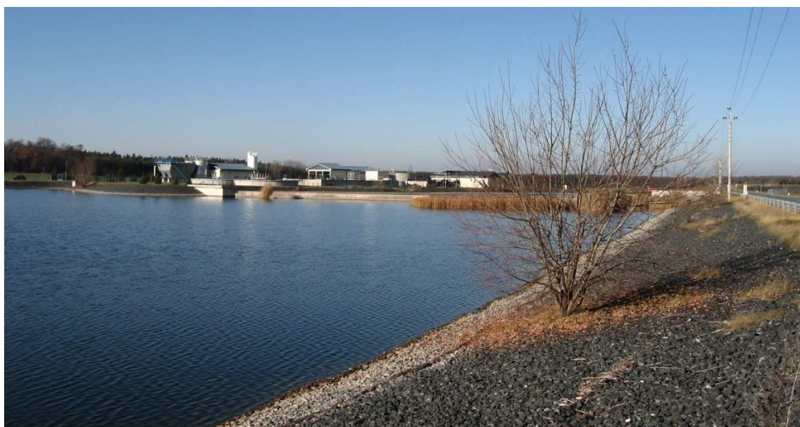
Obr. 13 ČOV a retenční nádrž v průmyslové zóně (Jiří Pospíšil, prosinec 2012)
