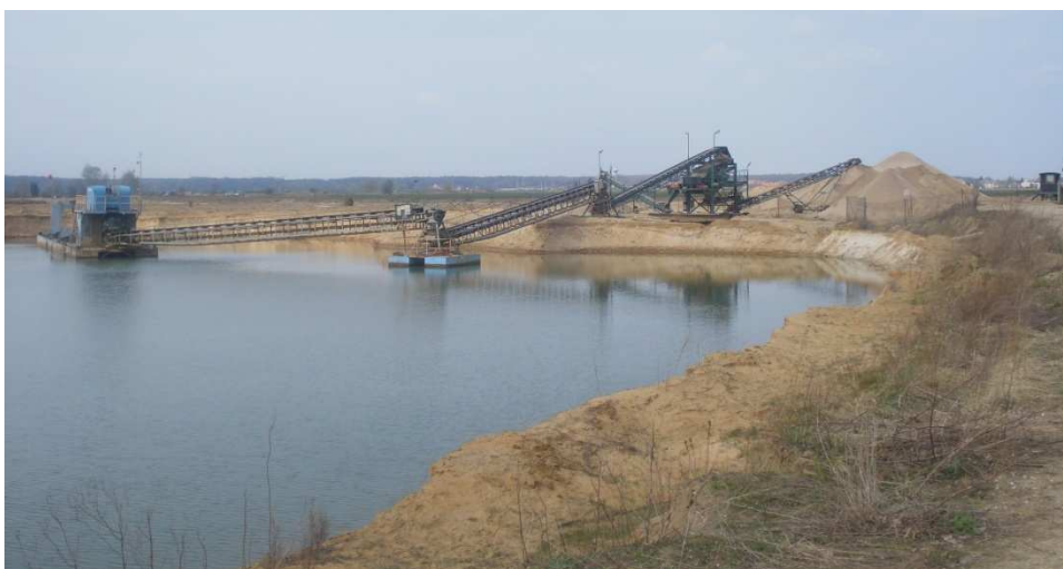
Obr. 5 Těžba štěrkopísků u Veltrub (Jiří Pospíšil, březen 2012)
