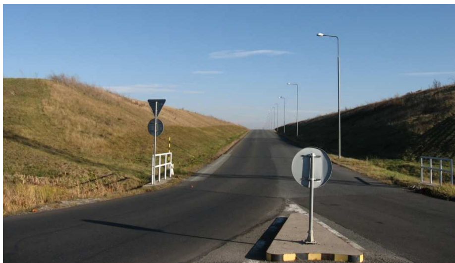
Obr. 9 Komunikační průkop v areálu průmyslové zóny (Jiří Pospíšil, prosinec 2012)
