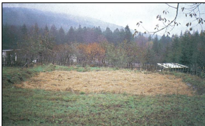
Obr. č. 7 - Kořenová čistírna v Dolní Černé Studnici, foceno r. 1993 (Vymazal, 1995, 114 s.)
