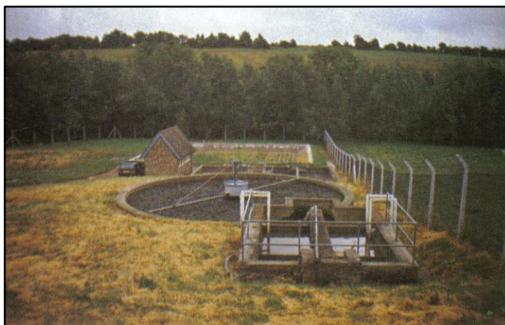
Obr. č. 10 – Combroke - typická sestava při čištění odpadních vod pro malé zdroje znečištění v okolí Birminghamu: usazovací nádrž – biofiltr – dosazovací nádrž – kořenová čistírna (Vymazal, 1995, 117 s.)
