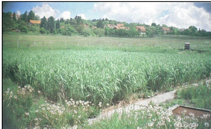
Obr. č. 6 - Kořenová čistírna v Ondřejově, foceno r. 1994 (Vymazal, 1995, 114 s.)
