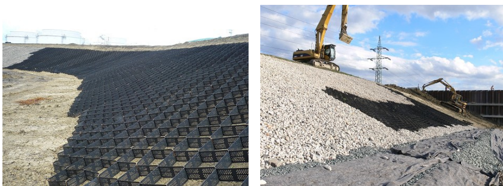
Obr. 39: Ochrana svahů pomocí geobuněk (GEOMAT, ©2021a).
