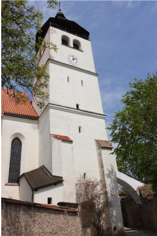
Nové Město nad Metují, Kostel Nejsvětější Trojice, exteriér, pohled na věž kostela od jihovýchodu – 1540.
