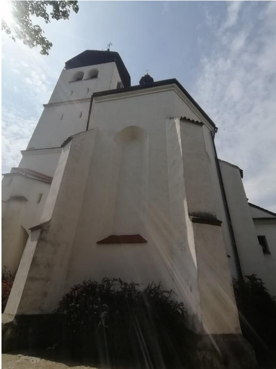
Nové Město nad Metují, Kostel Nejsvětější Trojice, exteriér, pohled na presbytář – 1540.
