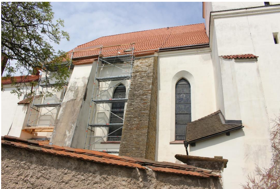
Nové Město nad Metují, Kostel Nejsvětější Trojice, exteriér, pohled na loď kostela od jihovýchodu – 1540
