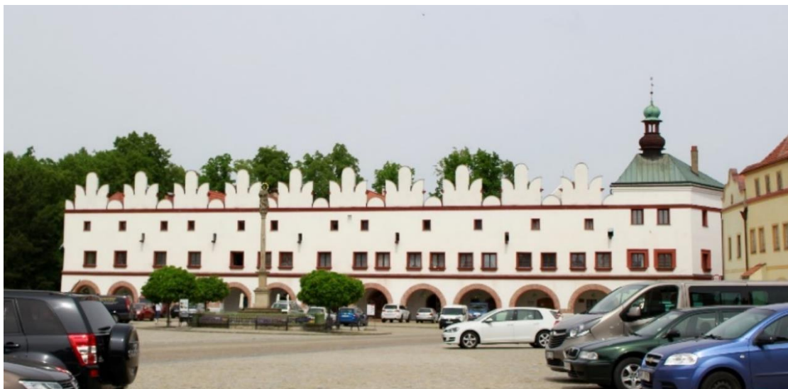
Nové Město nad Metují, náměstí, pohled od jihovýchodu – po roce 1533.
