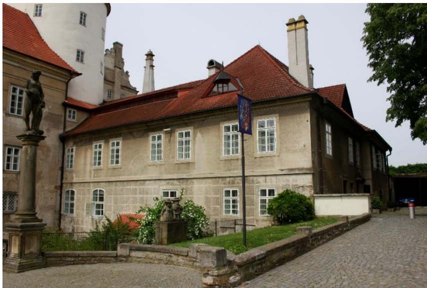
Nové Město nad Metují, dům 2A, pohled od jihovýchodu – 1580
