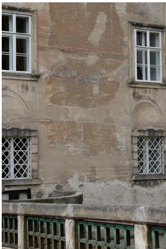
Nové Město nad Metují, zámek, exteriér, hlavní průčelí zámku, detail chiaroscurové fasády, přízemí – 1590-1620.
